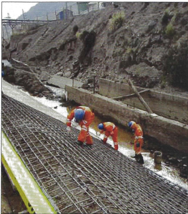
Vista de Proceso de Enfierrado a cargo de la empresa contratista.
