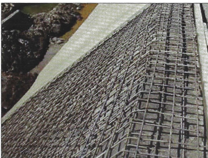
Vista de Armadura de Fierro una vez terminada, se ve también Wáter Stop para las juntas
