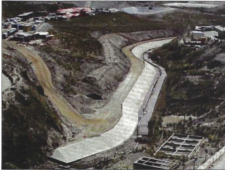
Vista Panorámica aguas abajo después de la construcción del Muro.
