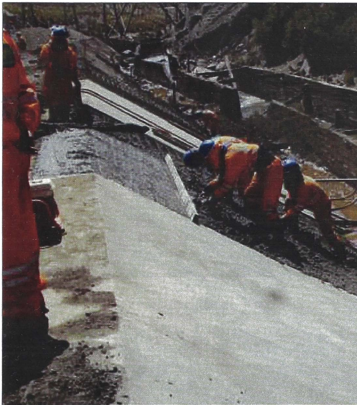
Vista de Vaciado de concreto en Obra Defensa Ribereña - Carahuacra
