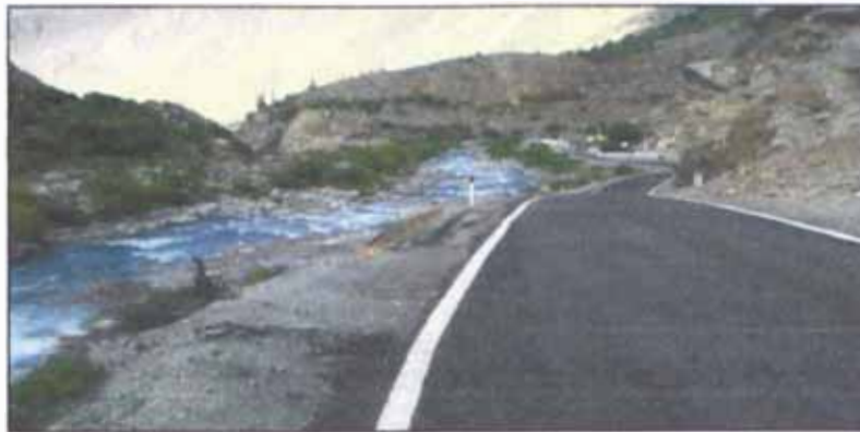
Fig. 2.09: Tramo de la carretera Cañete-Chupaca con peligro de inundación.
