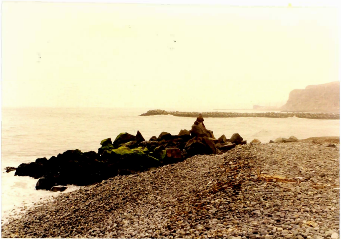
11.- VISTA DEL LADO SUR DEL ESPIGON Nº 9 ZONA DE ARENAMIENTO
