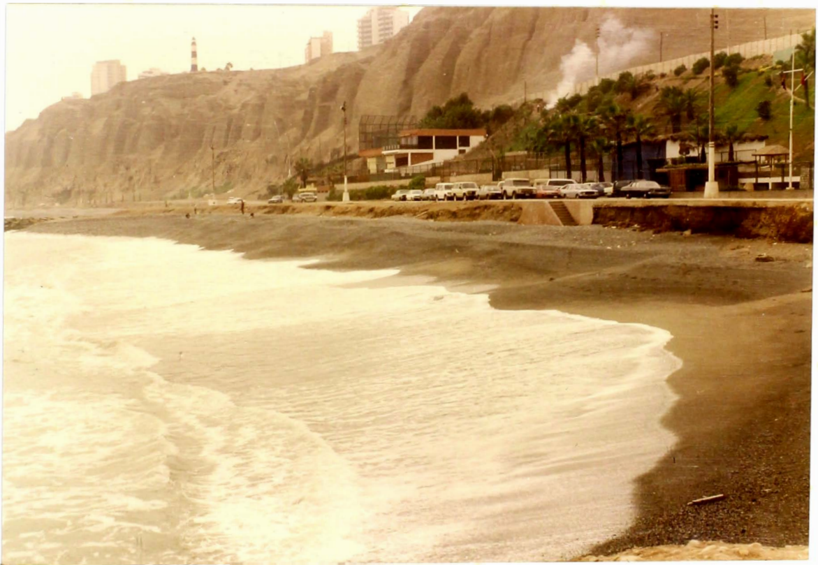
12.- VISTA DEL TRAMO ENTRE LOS ESPIGONES Nº 9 Y 10
