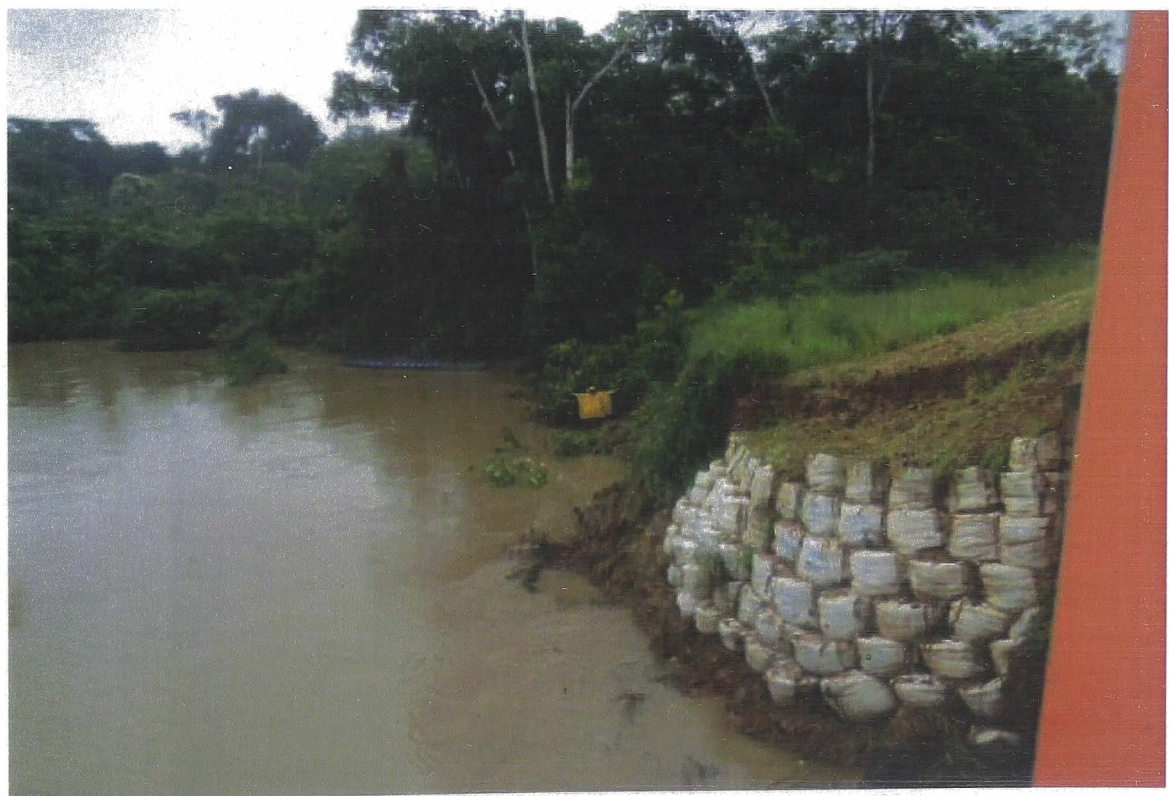
Foto N°02: Protección del estribo izquierdo aguas arriba del puente Mavila.
