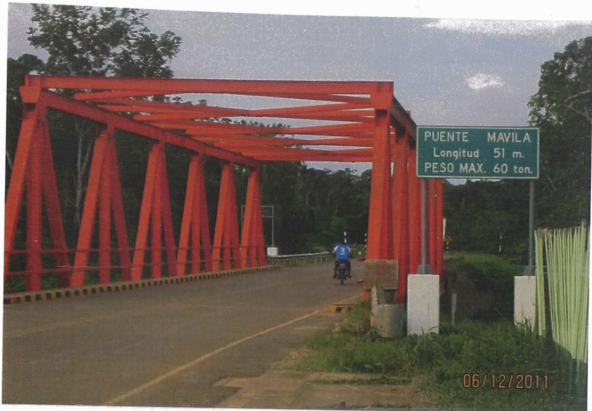
Foto N°01: Puente Mavila. Forma parte del Tramo III del Corredor Vial Interoceánico Sur. Dic.2011
