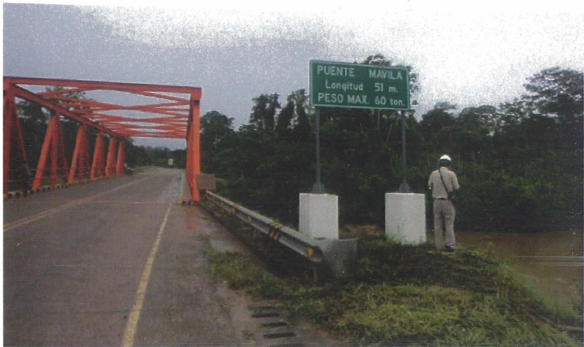
Foto N°01: Puente Mavila. Forma parte del Tramo III del Corredor Vial Interoceánico Sur. Ene2012
