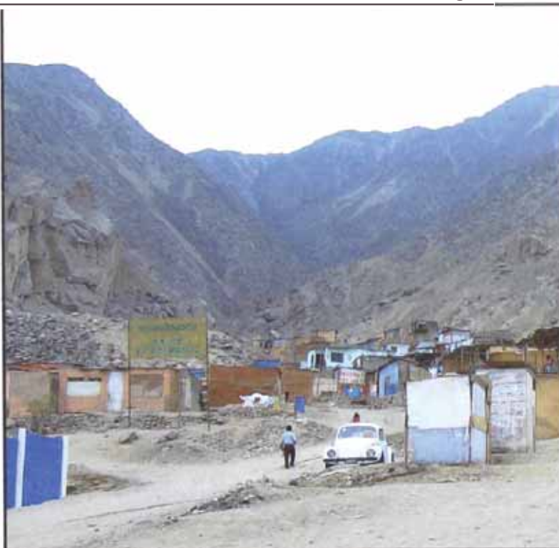
Foto N° 6.06. En la foto se observa como las viviendas se ubican en la salida de la quebrada, estas viviendas podrían sufrir graves daños en una eventual presencia del fenómeno (asentamiento humano 27 de marzo, zona de Tahuantinsuyo).
