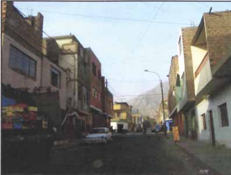
Foto N° 6.02. Los cables eléctricos, están muy cerca de las viviendas, estas no respetan la distancia de seguridad.
