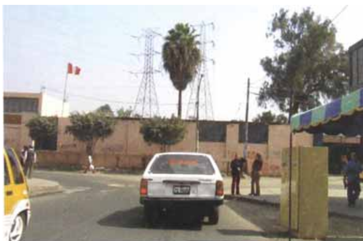
Foto N° 6.01. El Colegio Estatal N° 2034 “República de Irlanda” ocupa parte de la franja de servidumbre de los cables eléctricos de alta tensión (Jr Educación s/n en la zona de Independencia, distrito de Independencia).
