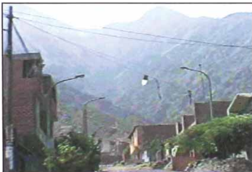
Foto N° 6.13. P. J. "Carmen Alto", los postes de electrificación podrían verse afectados por el arrastre de lodo en una eventual presencia de "El Fenómeno del Niño".
