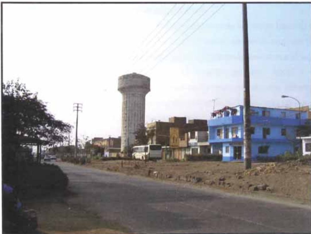
Foto N° 4.04. Se aprecia un tanque elevado ubicado a la altura de la 3 ra cuadra en la Av. Industrial, es uno de los dos tipos de reservorios que tiene en el distrito de Independencia.
