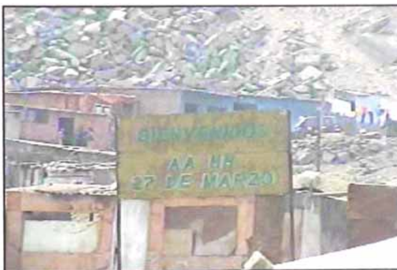
Foto N° 6.07 A. H. "27 de Marzo", las viviendas son de madera con techo de eternit o cartones, en un movimiento sísmico las piedras de la parte superiores podrían caer y causar pérdidas materiales y humanas.
