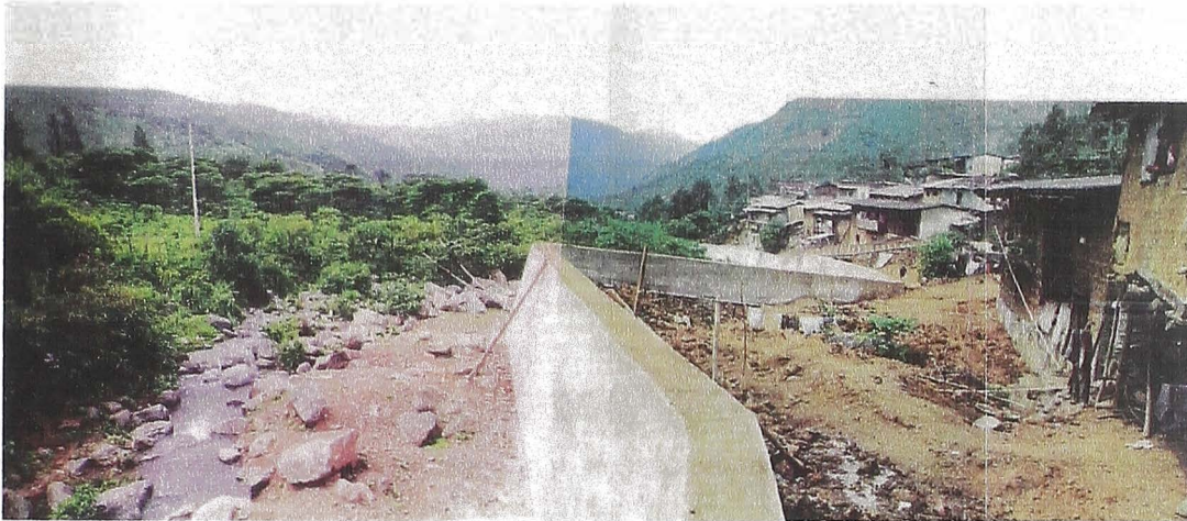
Fotografía 1-3 Muro de concreto ciclópe terminado (Octube-97)
