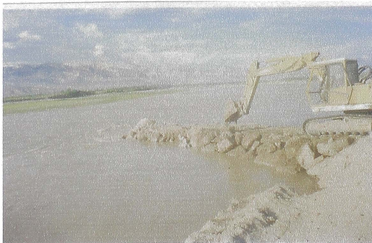
Fotografía 3-5 Conformación del dique con retroexcavadora
