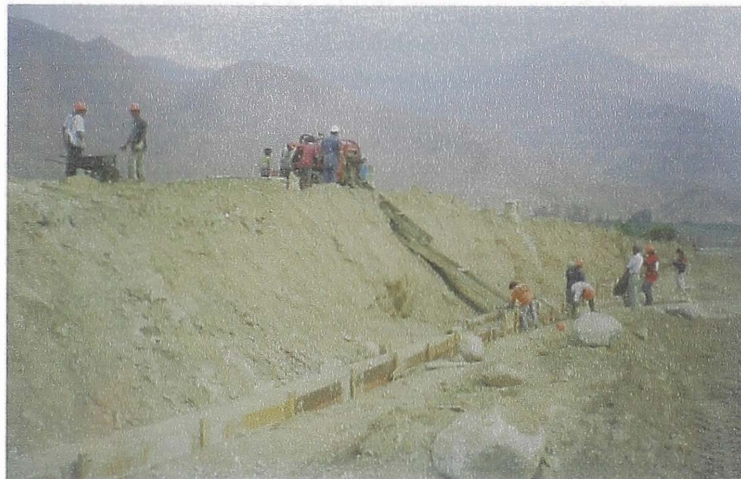
Fotografía 2-6 Vaciado de uña estabilizadora
