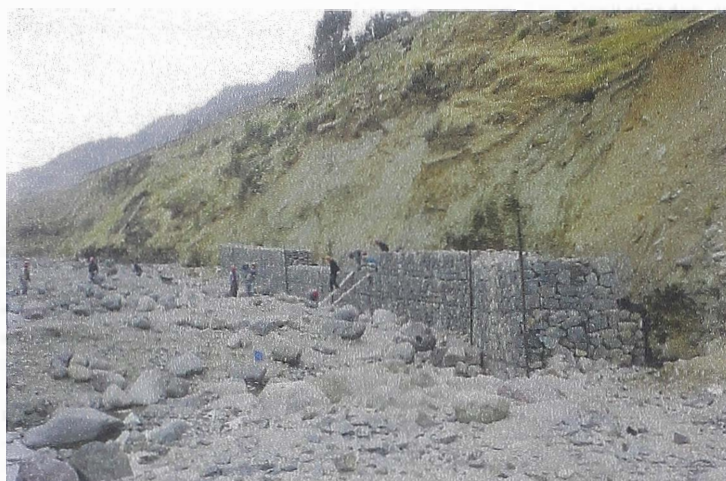
Fotografía 4-6 Colocación del tercer nivel del muro
