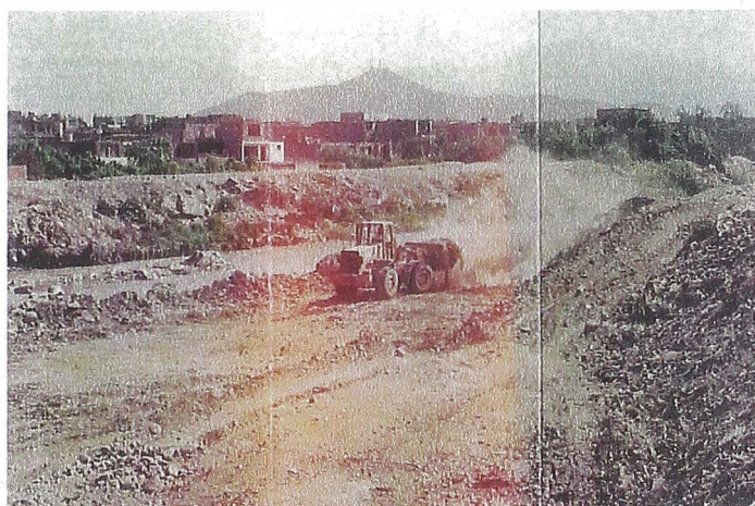
Fotografía 2-3 Acondicionamiento de los taludes laterales
