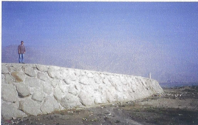
Fotografía 5-6 Enrocado con las juntas rellenas, dique terminado
