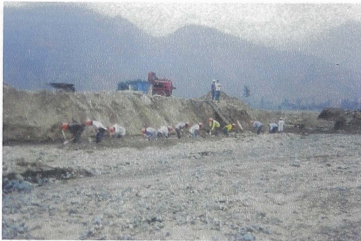
Fotografía 1-6 Excavación de uña estabilizadora
