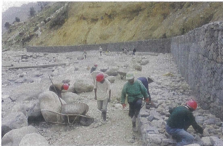
Fotografía 2-6 Relleno del colchón Reno
