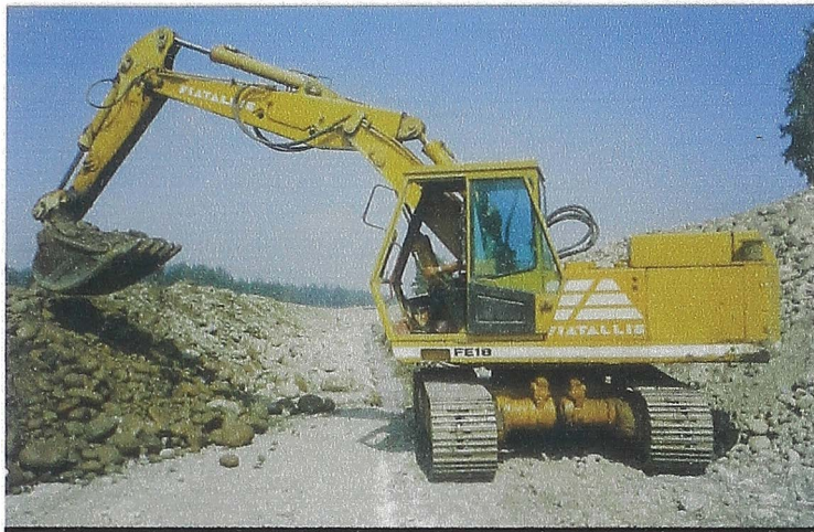
Fotografía 1-6 Excavación de zanjas para cimentaciones
