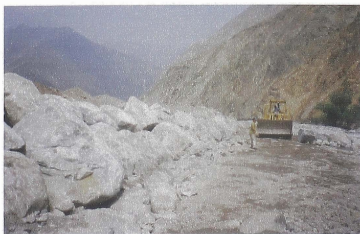
Fotografía 3-4 Limpieza del cauce
