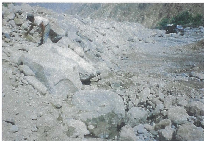
Fotografía 2-4 Colocación del enrocado en la cara húmeda
