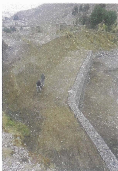
Fotografía 6-6 Muro relleno compactado en los espaldones
