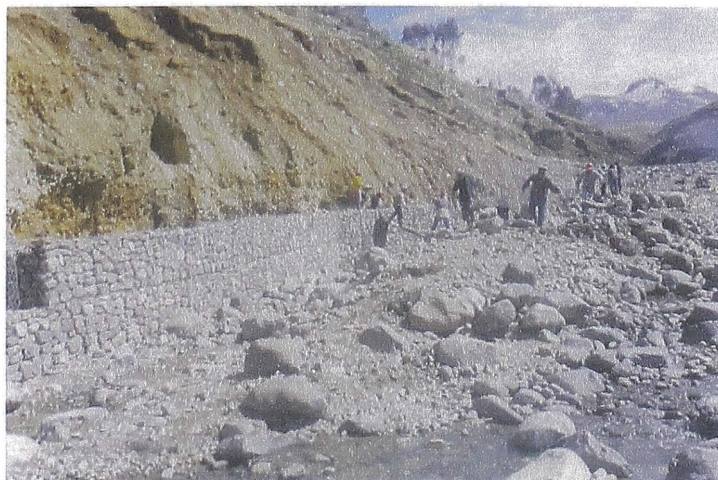
Fotografía 3-6 Colocación del segundo nivel del muro
