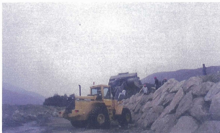
Fotografía 3-6 Colocado del enrocado en la cara húmeda
