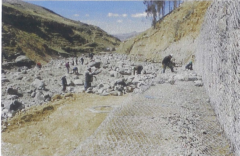
Fotografía 1-6 Armado de malla de colchón Reno
