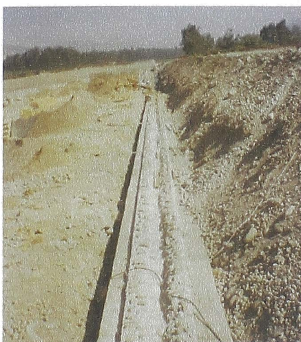
Fotografía 3-6 Cimentación Vaciada
