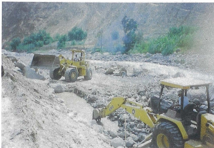
Fotografía 1-4 Excavación de ña estabilizadora
