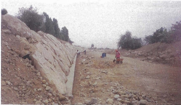
Fotografía 4-6 Uña estabilizadora y enrocado terminado
