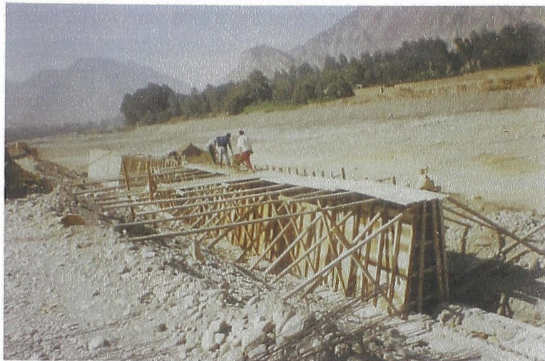
Fotografía 4-6 Encofrado de pantalla del muro
