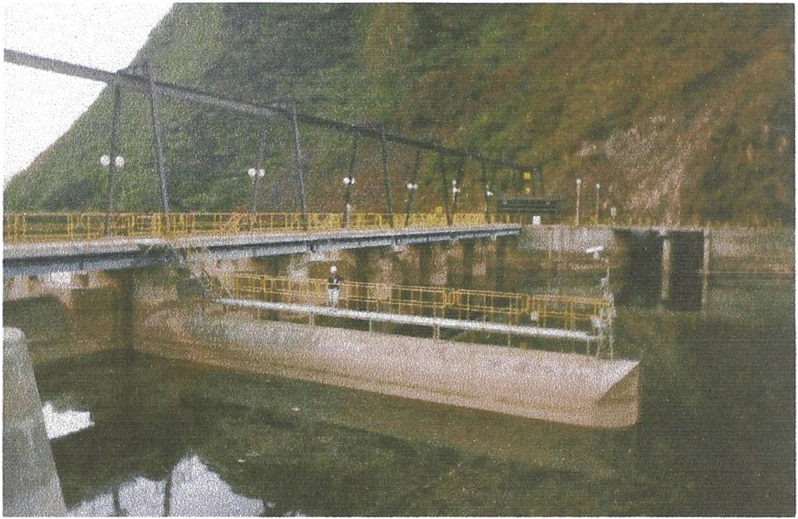
FOTO N° 11.- COMPUERTAS DE LA TUMA TULUMAYO: SE COMPONEN DE 3 COMPUERTAS EN LA PARTE BAJA Y DE TRES COMPUERTAS EN LA PARTE ALTA, ESTAS COMPUERTAS SON RADIALES.
