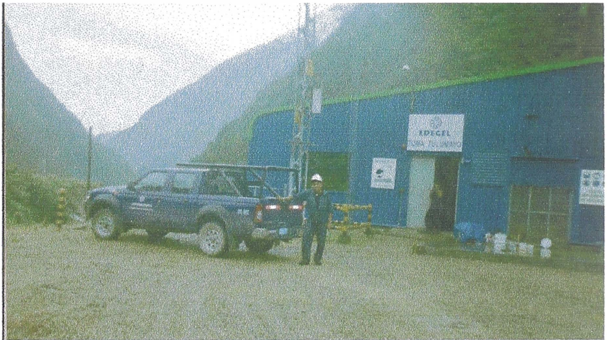
FOTO N° 10. - CASETA DEL TOMERO. ENCARGADO DE LA REGULACIÓN DE LAS COMPUERTAS Y TOMA DE CAUDALES LOS CUALES SON REPORTADOS A LA CENTRAL CHIMAY
