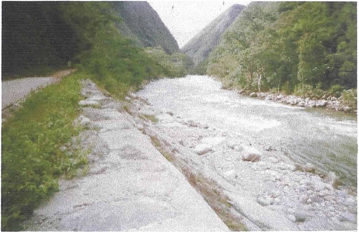
FOTO N° 03. - CAUCE DEL RIO TULUMAYO AGUAS ABAJO DE LA CENTRAL CHIMAY
