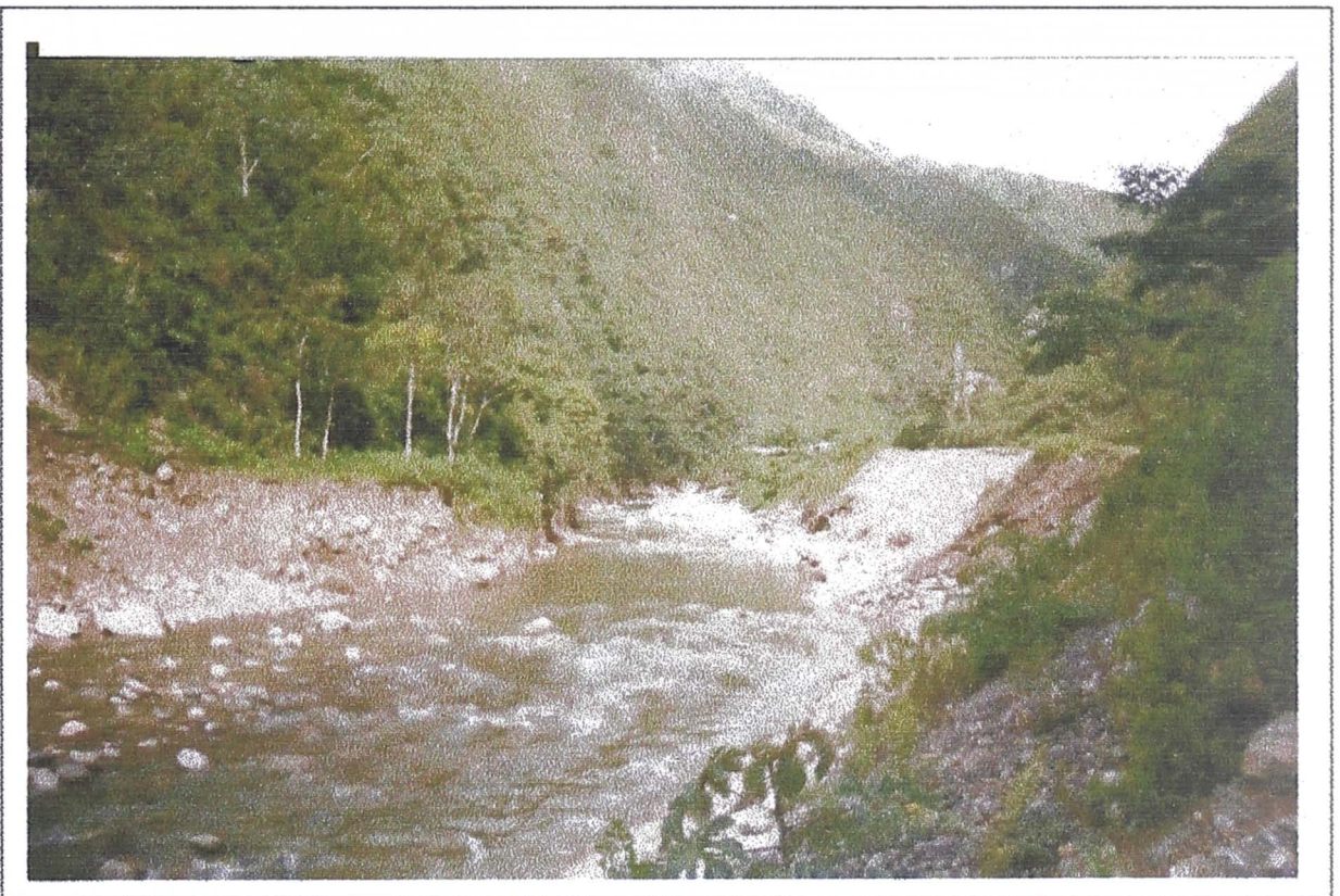
FOTO N° 02. - CAUCE DEL RIO TULUMAYO AGUAS ARRIBA DE LA CENTRAL CHIMAY
