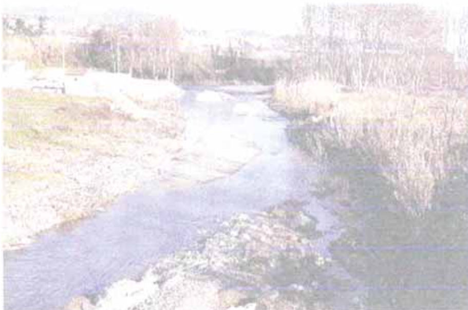
Erosión en las Márgenes de un río
