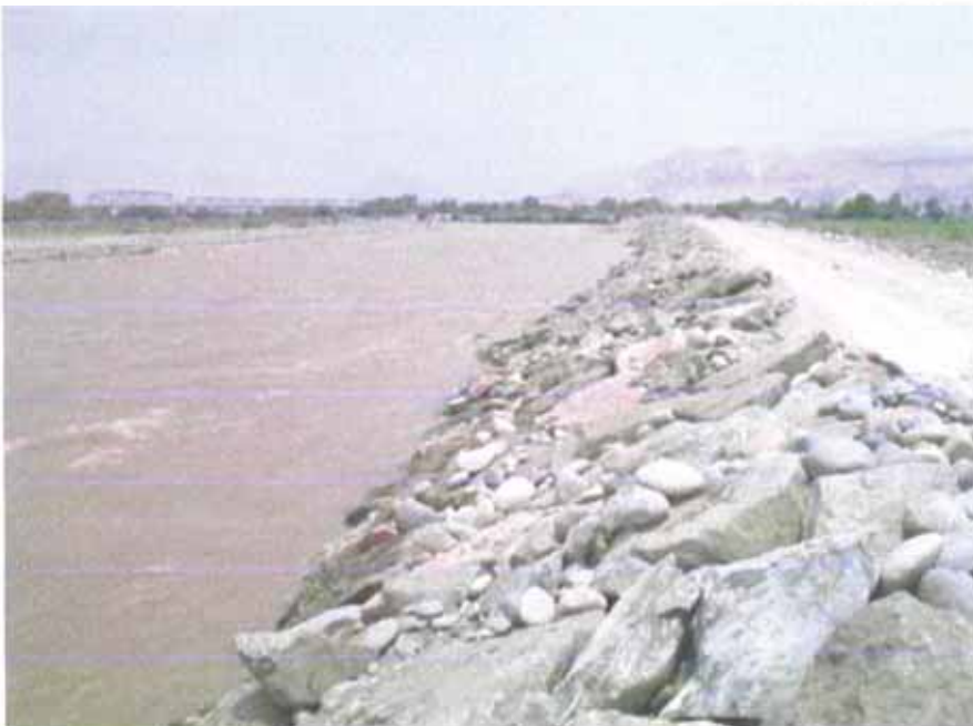
Utilización de Enrocado como protección de Riberas
