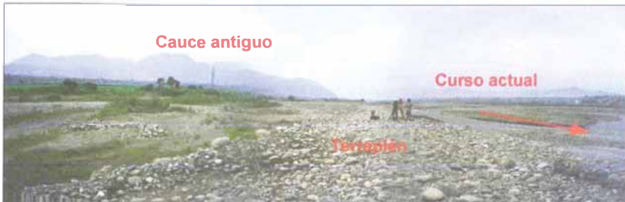
Figura 2. Esta fotografía muestra el cauce antiguo, que ha sido separado del cauce actual mediante un terraplén en la margen derecha.
