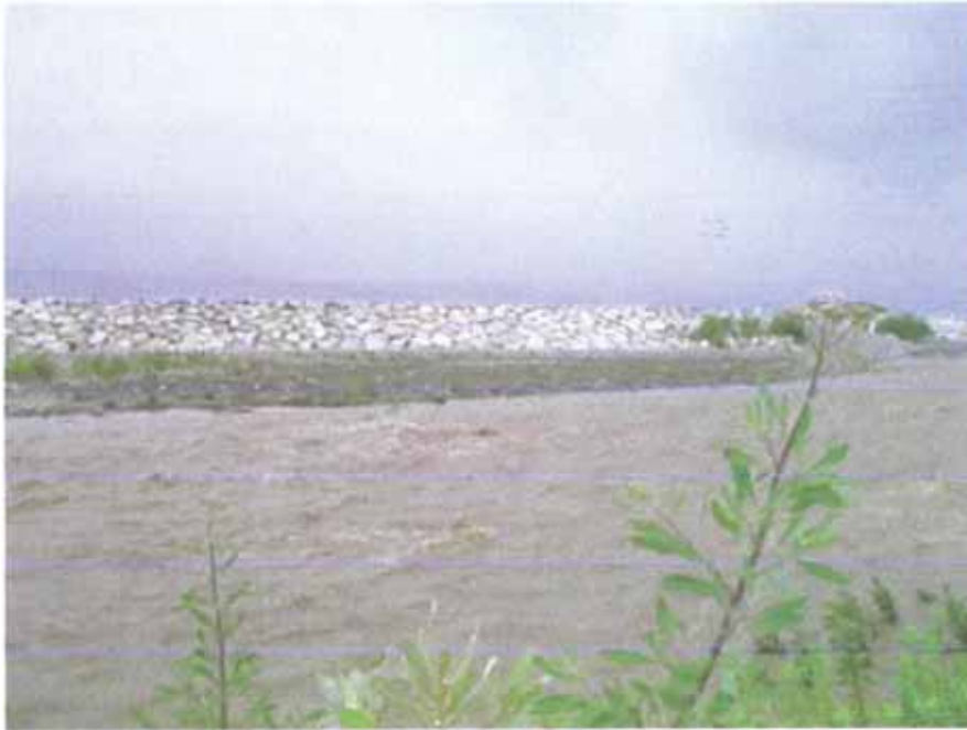
Defensa ribereña utilizando Enrocado
