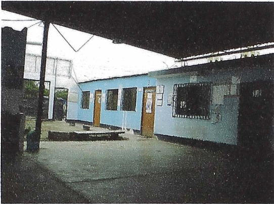
Se observa que la construcción está muy dañada y con pocos elementos estructurales sismo resistentes
