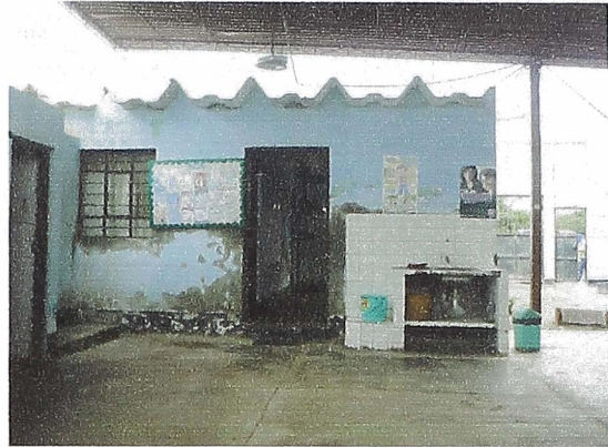
Se observa que la construcción está muy dañada y con pocos elementos estructurales sismo resistentes
