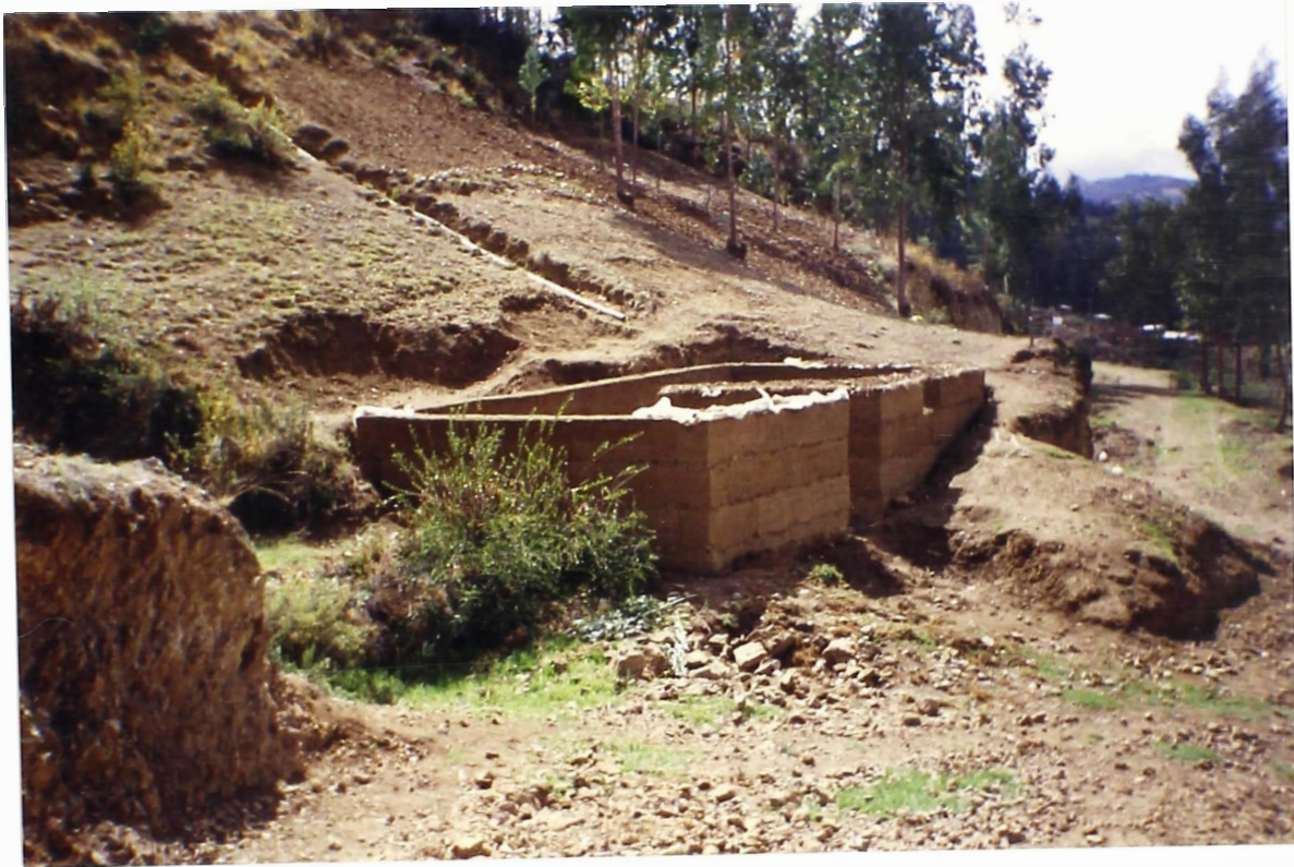
FOTO 4 CONSTRUCCION DE VIVIENDA DE ADOBE EN PROCESO
