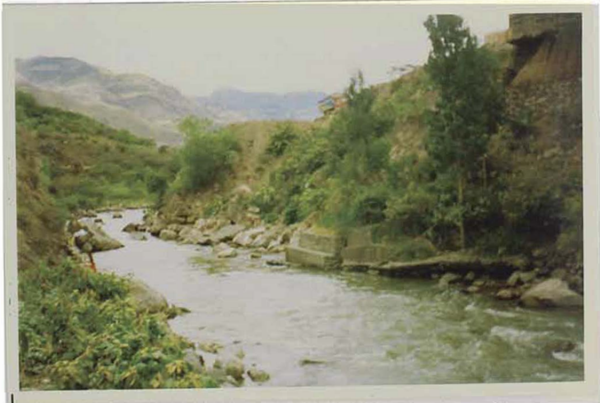
6) Deslizamientos en la margen izquierda del río Huancabamba y grieta que baja hacia el río originando el colapso del puente antiguo.
