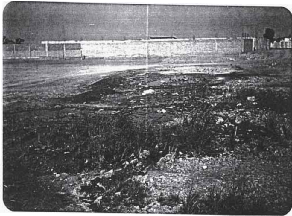
Foto 12.- La constante rotura de las pocas tuberías de desagüe, completamente vulnerables, producen charcos de aguas servidas en la parte baja como se aprecia en la foto.
