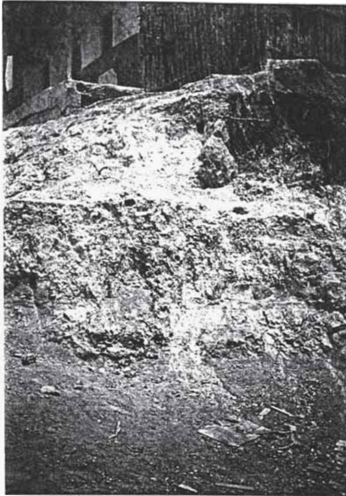
Foto 8.- Foto tomada desde una calle en la parte alta, hacia las viviendas. Se aprecia como estas viviendas están en un nivel más alto que la pista, debido a la erosión en esta por las lluvias.
