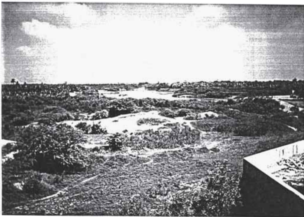
Foto 13.- El funcionamiento de la planta de tratamiento de agua, depende de las variaciones del cauce del río. En la foto se aprecia la distancia de aproximadamente 300 mts. de la planta al río. Antes de 1983 esta planta estaba a orillas del río.
