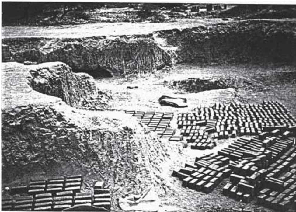
Foto 11.- Fábrica informal de unidades de albañilería. Como se observa, la arcilla utilizada es tomada sin pasar ningún control.
