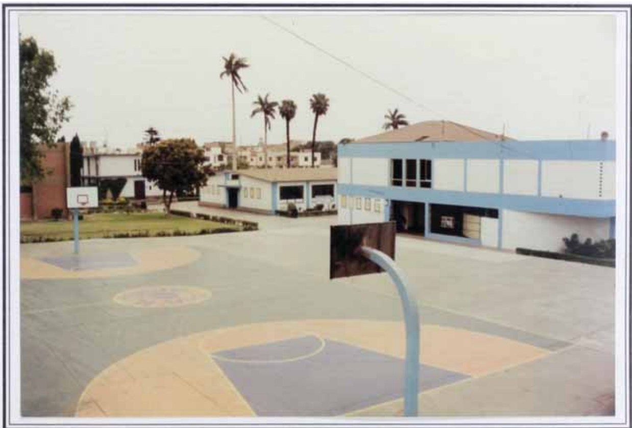
Foto N°32: Vista interior de las instalaciones del Colegio San Antonio Marianistas, en donde se albergará temporalmente la población damnificada.
