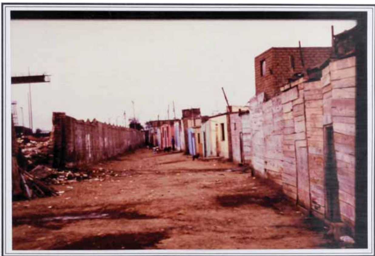
Foto N°18: Pueblo Joven Puerto Nuevo. En esta toma observamos viviendas inseguras y de poca estabilidad, que es característico en esta población de baja condición social. Se aprecian viviendas junto a un basural, poniendo en peligro la salud de sus pobladores.
