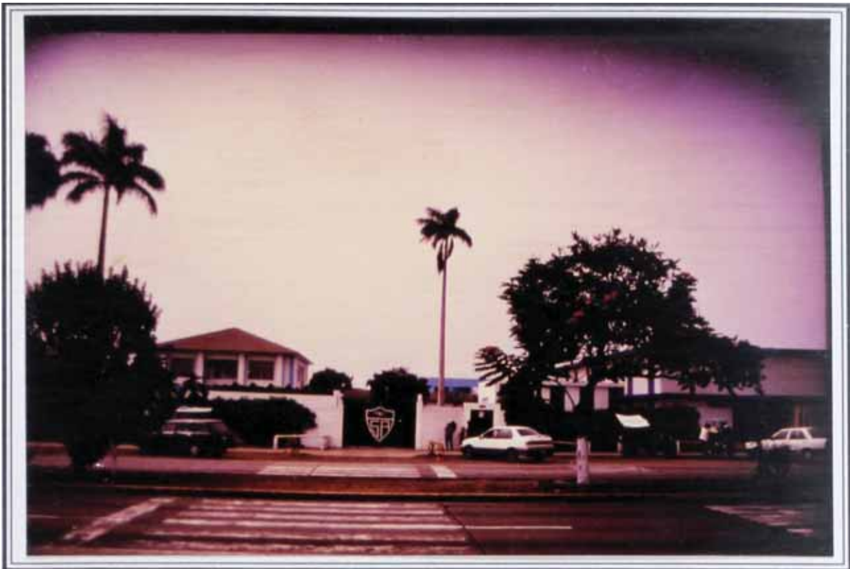
Foto N°31: Colegio San Antonio Marianistas (de Varones). Se encuentra ubicado en la avenida Guardia Chalaca y se propone como refugio temporal.
