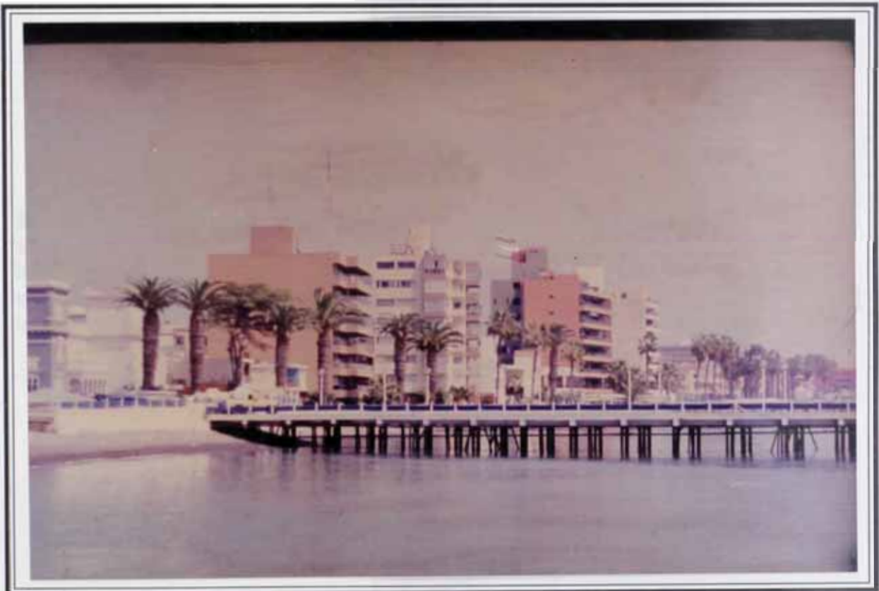
Foto N°6: Edificios Ubilluz, Caprice y Brescia. Propuestos como refugios de emergencia ante la alarma de tsunami. Se encuentran ubicados en el Malecón Figueredo y las calles García y García, Moore y Ferré, respectivamente, en el distrito de La Punta.
