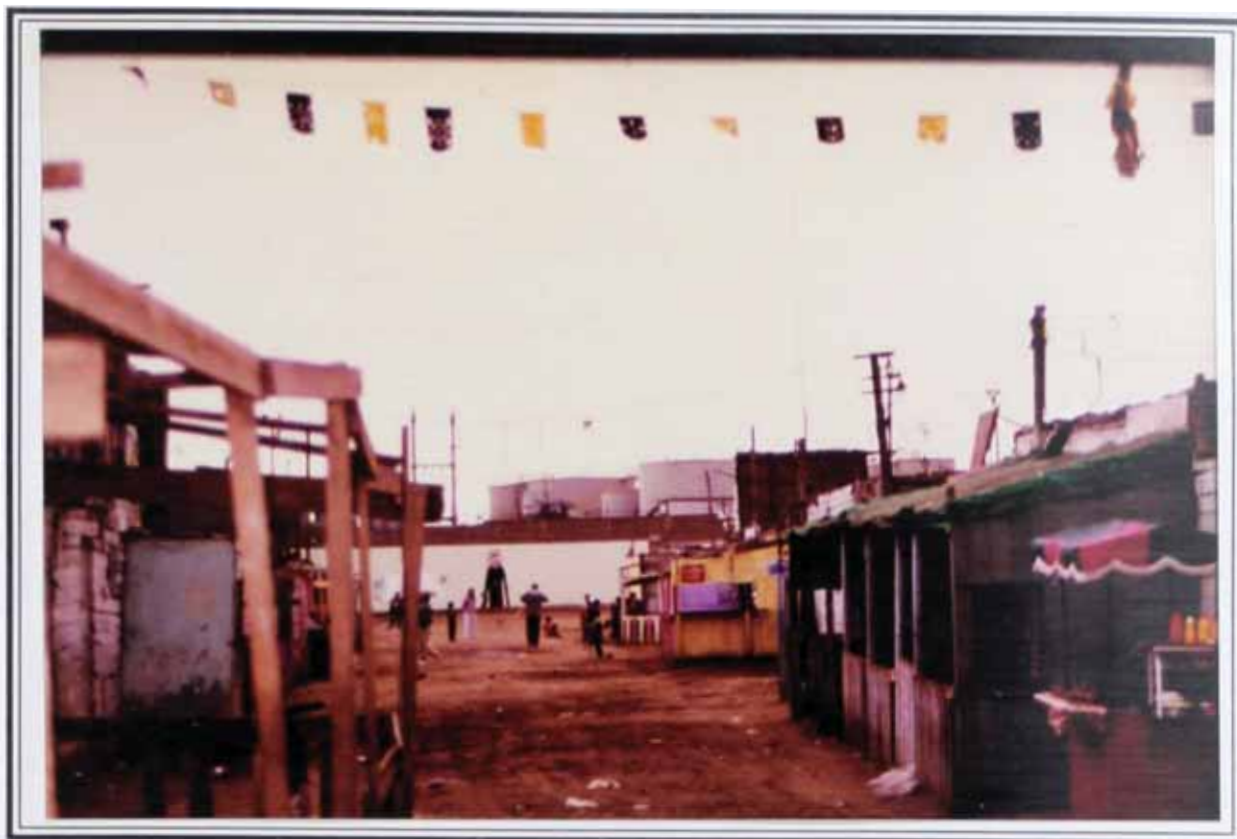
Foto N°17: Pueblo Joven Puerto Nuevo. Viviendas de material muy precario, donde predominan las construcciones de madera. Se observa en la foto el alto riesgo ante la presencia de grandes depósitos y tanques de combustible.
