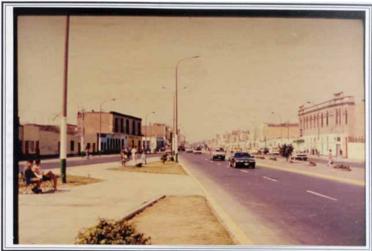
Foto N°11: Av. Almirante Grau (Ex Av. Buenos Aires). Considerada como vía de evacuación principal. Apreciamos a lo largo de la avenida, viviendas en regular estado de conservación hechas con material noble.
