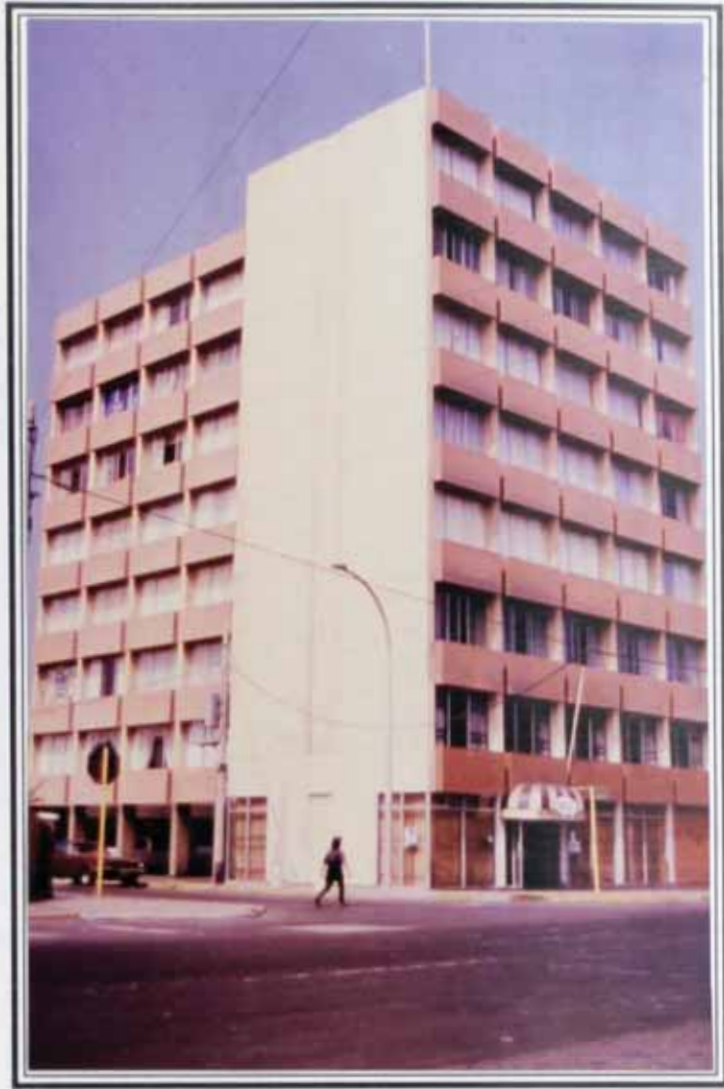
Foto N°5: Edificio Lercari. Señalado como refugio de emergencia en caso de alarma de tsunami, donde se albergará la población de La Punta que no podrá evacuar a tiempo. Se encuentra ubicado en la esquina de la Av. Grau y la calle Arrieta.
