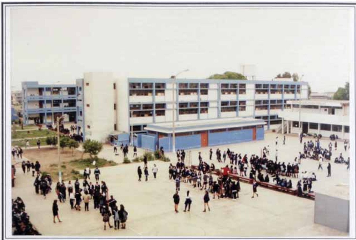
Foto N°29: Colegio General Prado. Vista interior de sus instalaciones, en donde se refugiara temporalmente la poblaci3n damnificada ante la ocurrencia de un tsunami.
