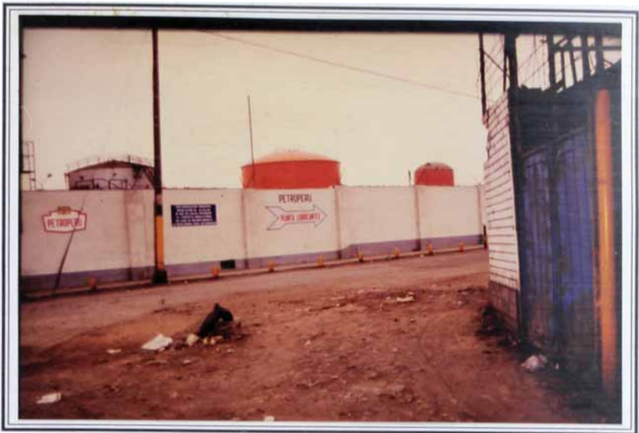
Foto N°19: Planta de PETROPERU. Se aprecian grandes tanques de almacenamiento de combustible.
