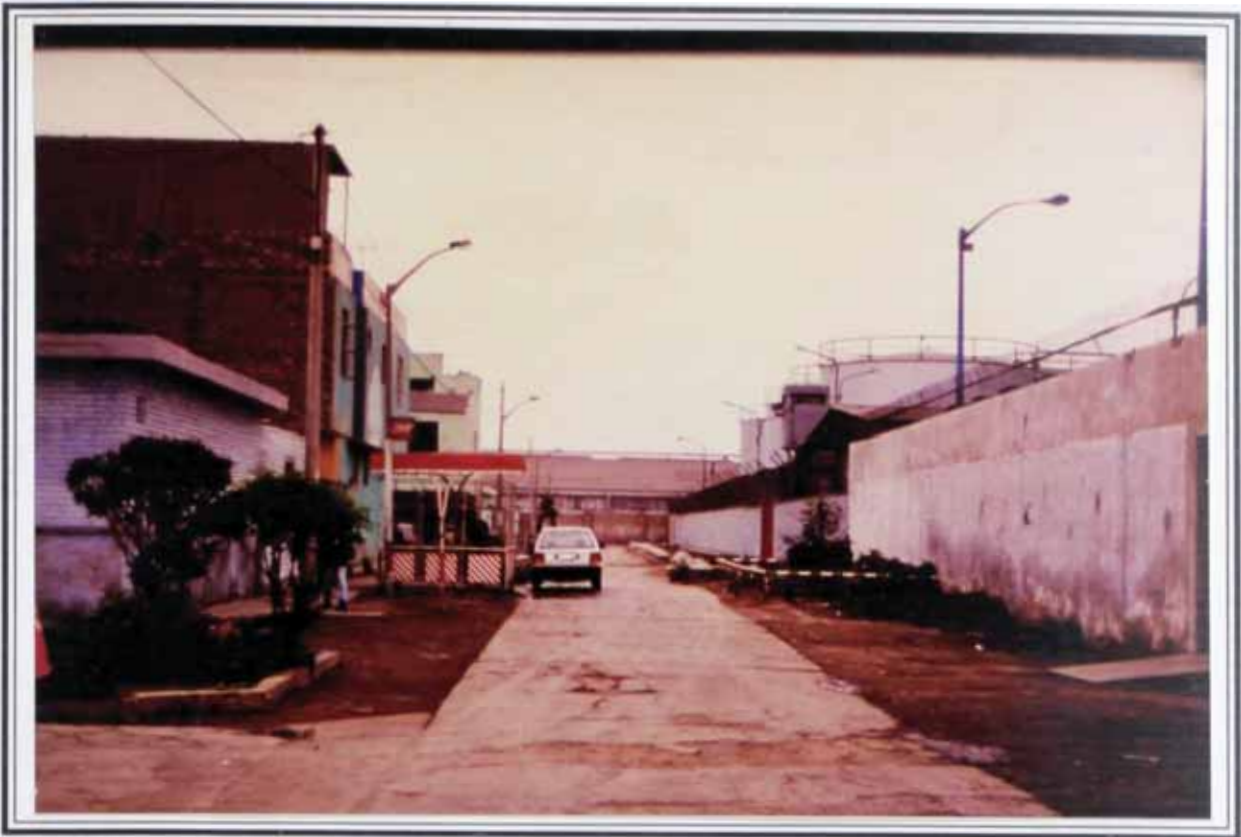
Foto N°21: Barrio Frigorífico. Esta toma es muy importante, ya que muestra el gran peligro al que están expuestos los pobladores de este sector, al verse separados de los tanques de combustible tan sólo por una calle angosta.
