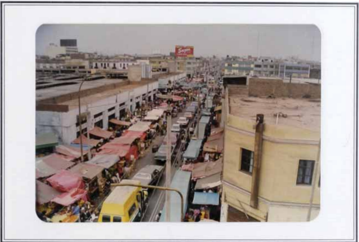
Foto N°22: Calle Colón. Vía de evacuación peatonal secundaria. Se observa el caos vehicular debido a la gran cantidad de comercio ambulante a lo largo de la vía. Esto debe erradicarse de inmediato.
