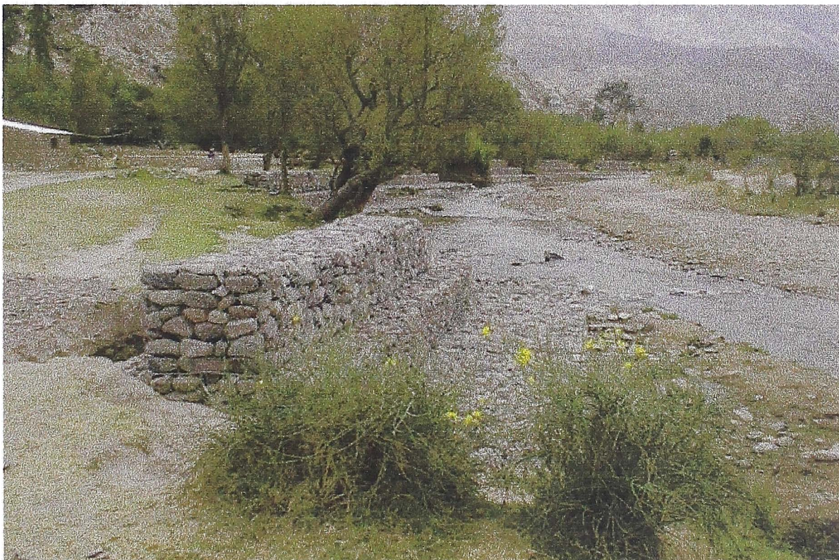
14.- En esta toma también se aprecia la ventaja que aporta los gaviones al medio ambiente (vegetación crecida en la defensa). Toma del río Llamoctachi-Ayacucho.
