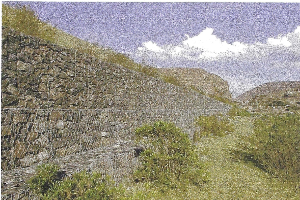
13.- En esta toma se vuelve apreciar un muro de contención con gaviones, también se ve claramente la vegetación crecida en el mismo, la cual produce un impacto positivo al ecosistema. Estructura ubicada en la ciudad de Huatanay departamento del Cuzco.
