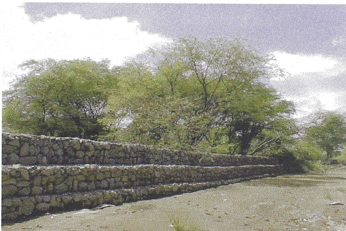
6.- En esta vista se muestra como el colchón reno o estructura antisocavante, esta cubierta de vegetación producto de las crecidas de las avenidas del río, asimismo la estructura ya se consolidó con el cauce o lecho del río.
