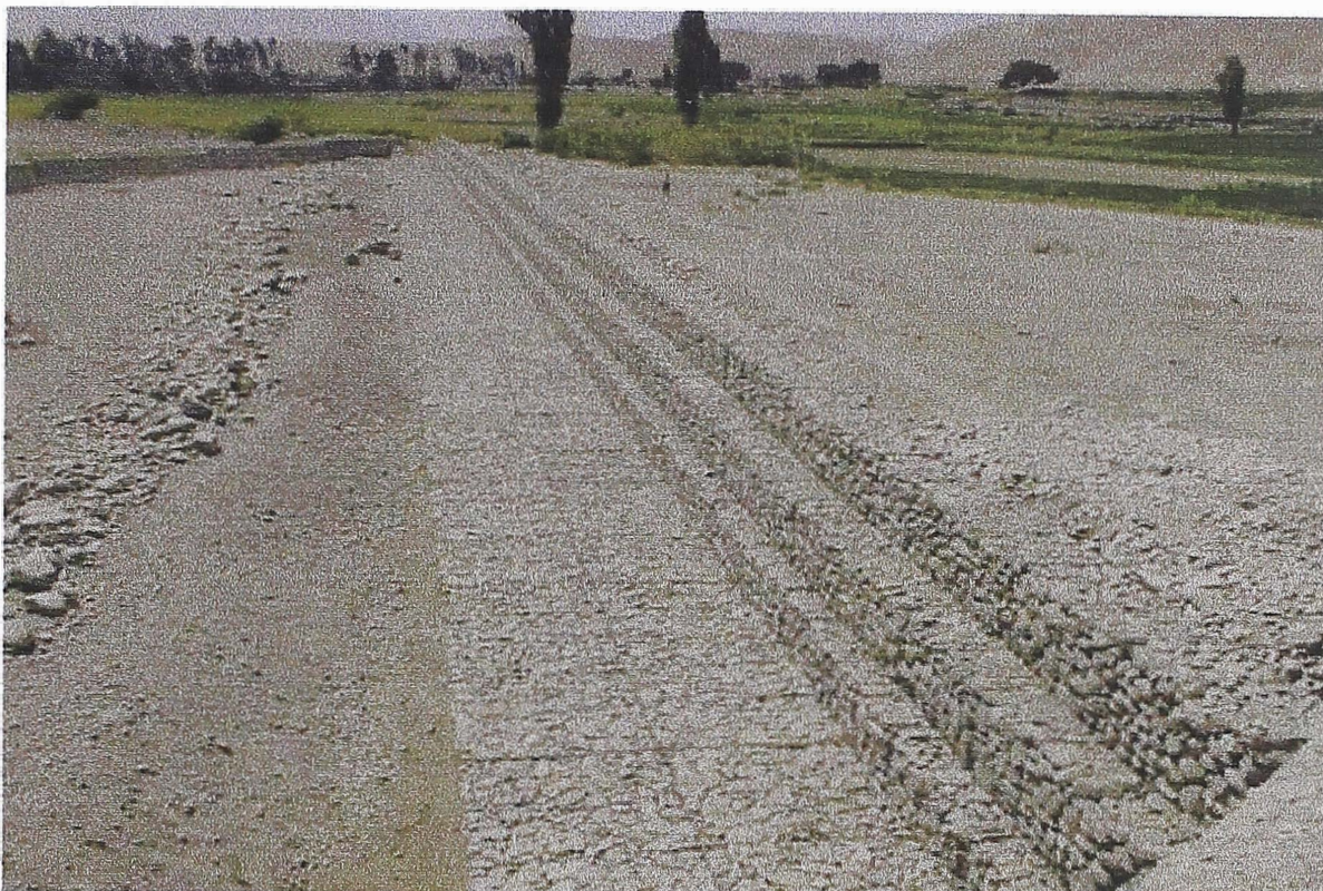
17.- En la toma se muestra la defensa de la margen derecha del río Montalvo en Moquegua, antes de que empiece a trabajar con cierto caudal.
