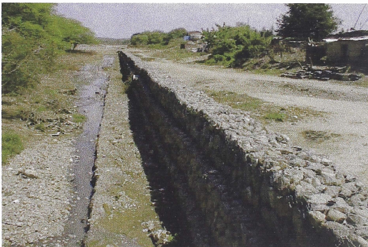
8.- En esta toma se puede apreciar el crecimiento de la vegetación en el colchón reno. Toma de la margen derecha de la Quebrada Carnero en Sullana Piura.
