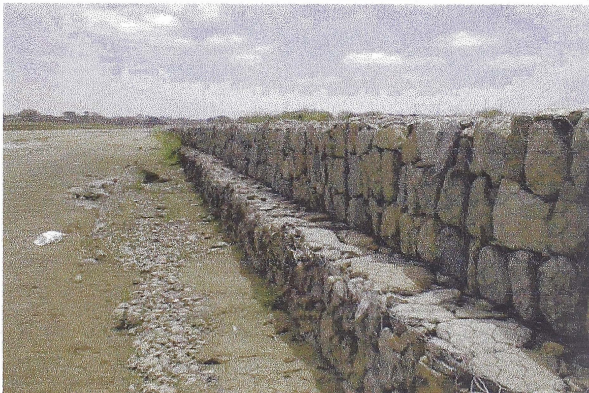
2.- En esta toma se muestra otro tramo de la defensa, también se aprecia la malla de los gaviones, así como el relleno con las piedras.
