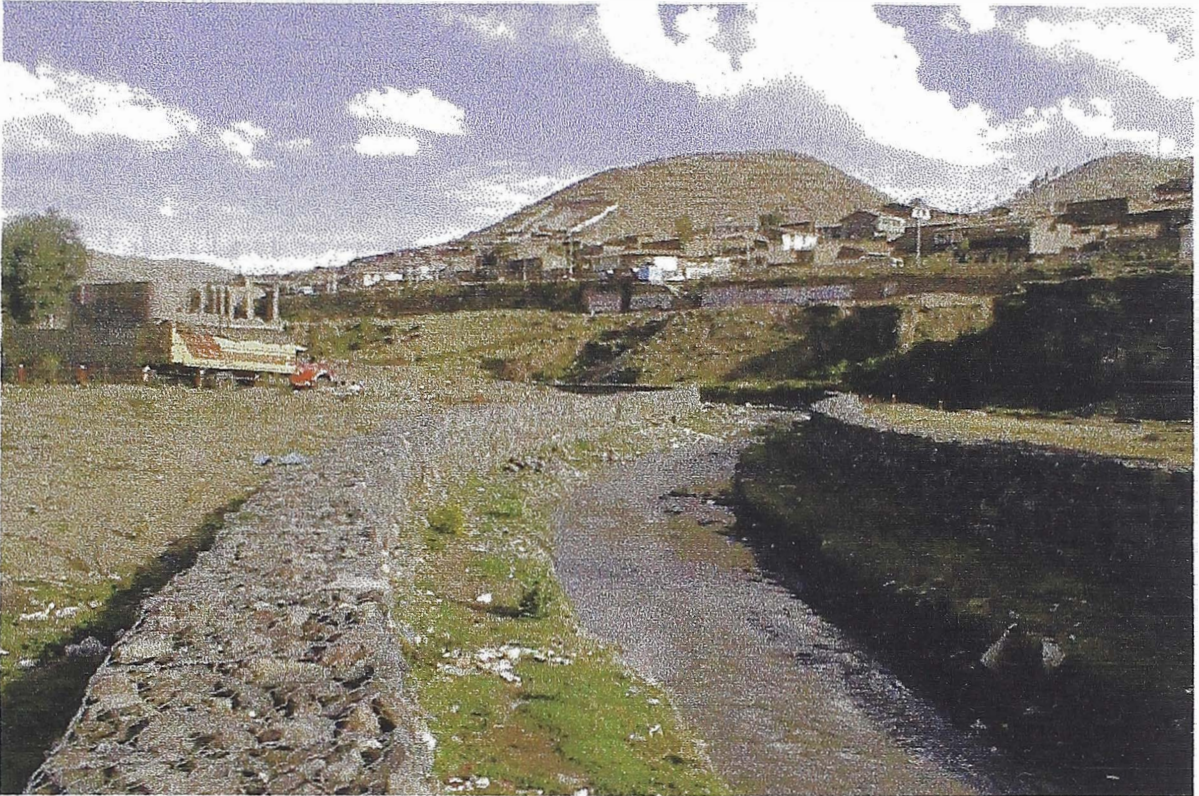
15.- En esta vista se muestra como el colchón reno esta en proceso de adherencia con el lecho del río y la ribera, debido al crecimiento de la vegetación. Defensa ubicada en la margen izquierda del río
