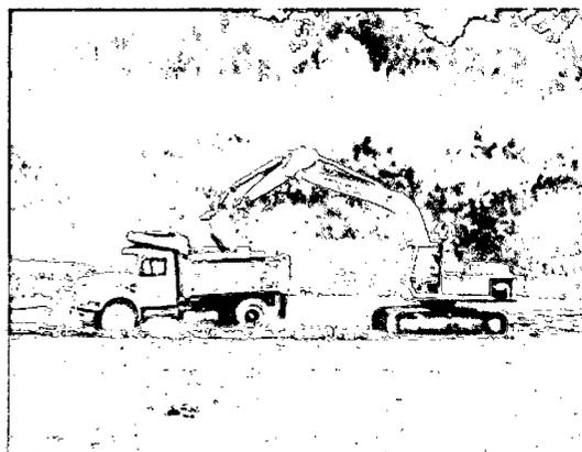
**Figura 1.5 a) Efecto de la extracción de sedimentos en un río.**
