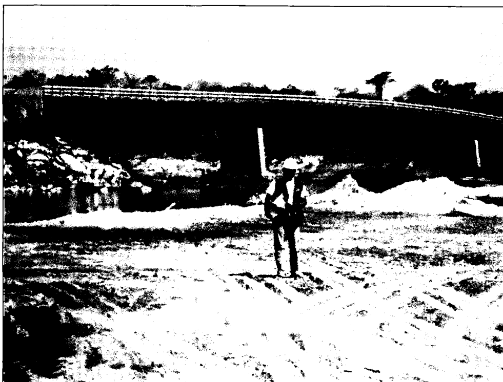
Figura N° A. 2 Lecho del río Tahuamanu aguas arriba del puente Tahuamanu.
