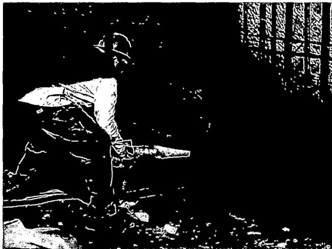
*Figura 1.4 Lanzado de concreto*
