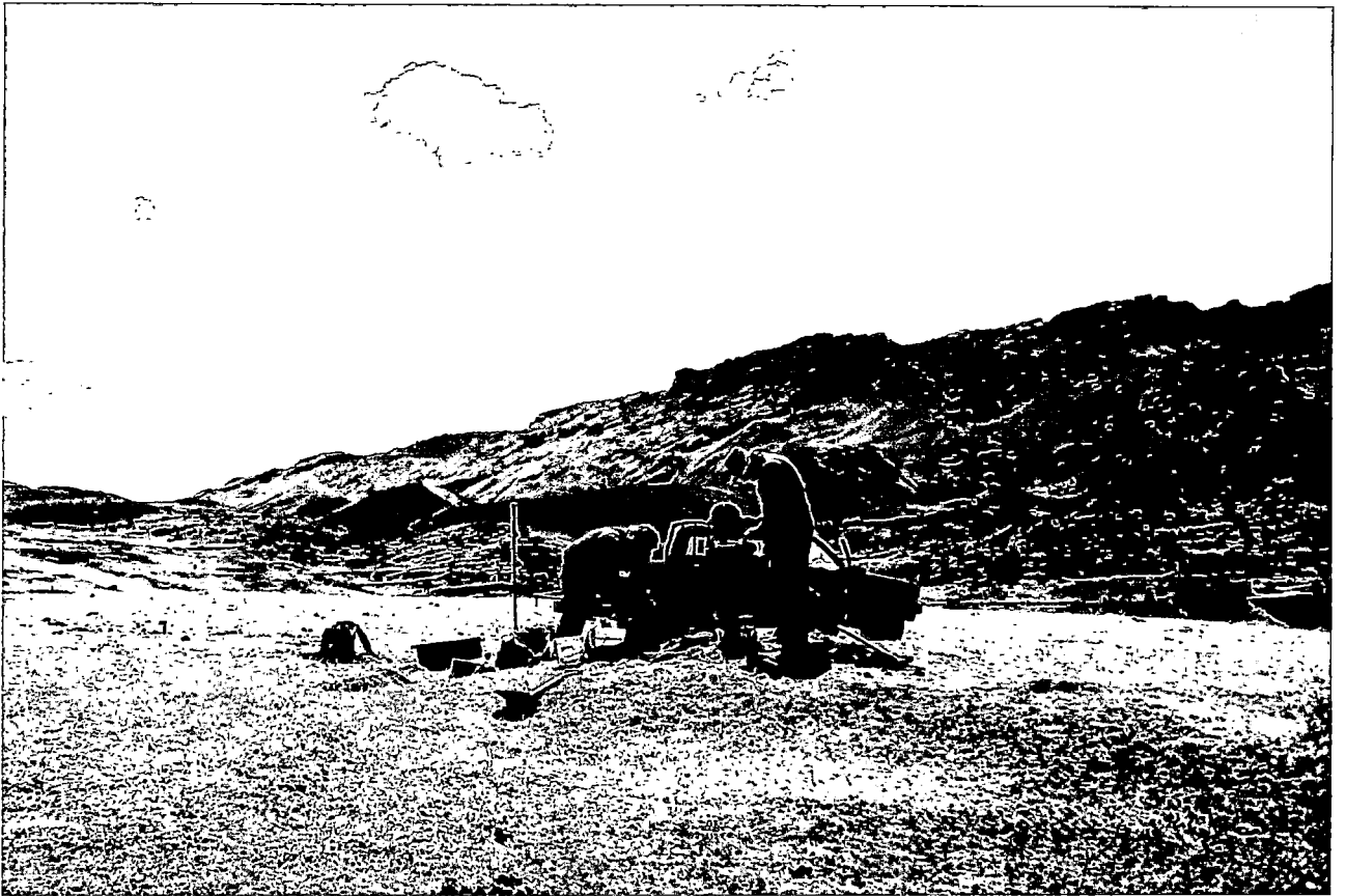
Figura B.2: En la imagen, se observa a G. Meza y el autor, construyendo un pilar para montar en telescopio C8 del GA de la FC-UNI con el objetivo de medir el seeing en la comunidad de Patacancha.
