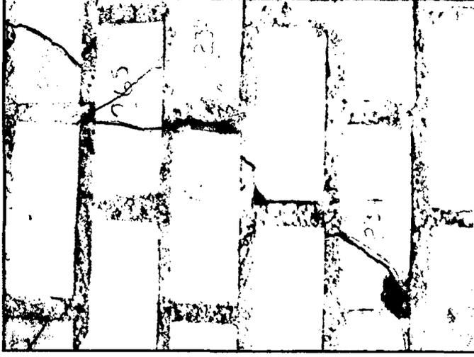
El agrietamiento diagonal en este muro se presenta de manera escalonada en gran parte.
