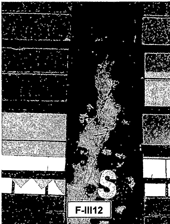
F-III12 y F-III13. Colegio Mariscal Cáceres - Tacna, la construcción data del año 1994. La interacción de los muros de mampostería con las columnas de concreto, ha generado fallas por columna corta debido a la nula o deficiente separación entre la mampostería y las columnas. Foto posterior al sismo del 23/06/01
