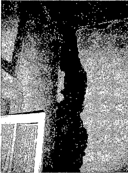
F-V01. Aprecie la grieta en la cercanía de la unión de muros ortogonales.
