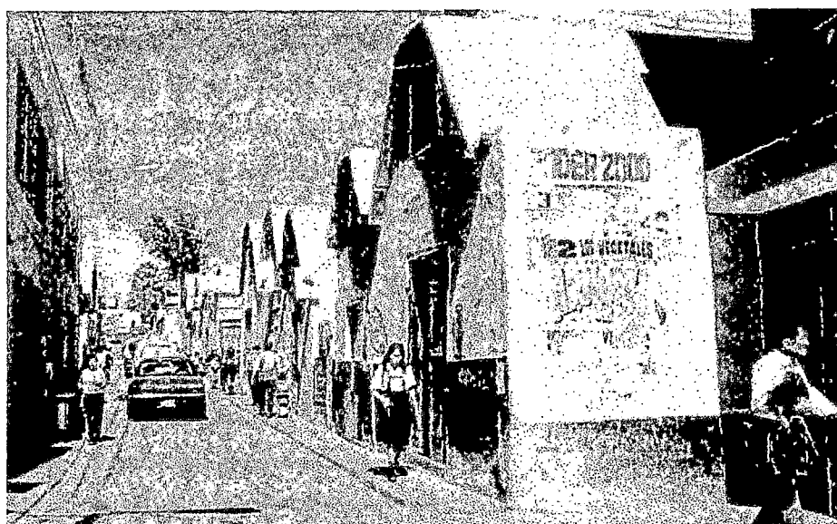
F-VI03. Calle Piura Cuadra 2 antes del sismo del 23 de Junio
