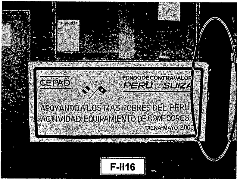
F-II16. Pabellón del Colegio Mariscal Cáceres de Tacna que no sufrió daños por falla clase columna corta debido a la adecuada junta sísmica, que se muestra en la parte marcada.
