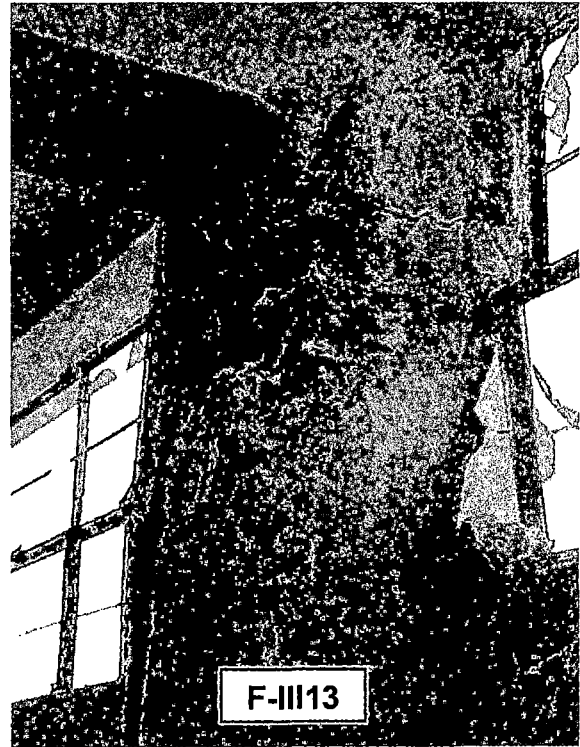
F-III12 y F-III13. Colegio Mariscal Cáceres - Tacna, la construcción data del año 1994. La interacción de los muros de mampostería con las columnas de concreto, ha generado fallas por columna corta debido a la nula o deficiente separación entre la mampostería y las columnas. Foto posterior al sismo del 23/06/01
