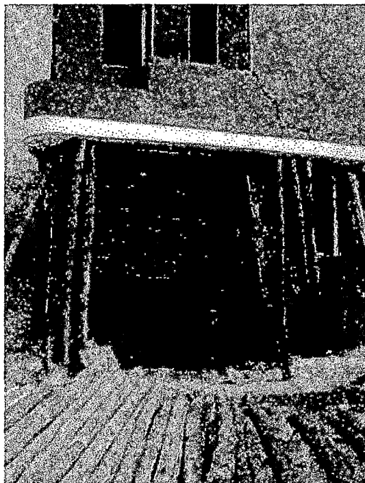
F-VI31. Apuntalamiento deficiente del primer nivel, debido a los graves daños causados en las columnas principales por el movimiento sísmico.
