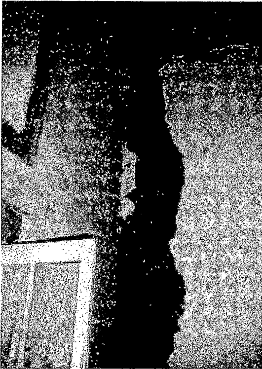
F-VI21 y F-VI22. Grieta por tracción en el encuentro de muros ortogonales, se midió el espesor de la falla y ésta era mayor a 5 cm.
