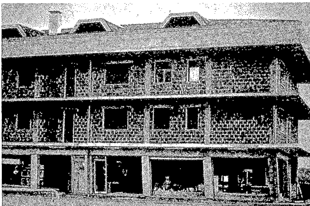
F-III19. Edificios que usan el primer nivel para cocheras donde el primer nivel no tiene muros a diferencia de los otros niveles, tienen poca resistencia al corte y por ello fallan o colapsan éstos edificios cuando ocurre un evento sísmico.
