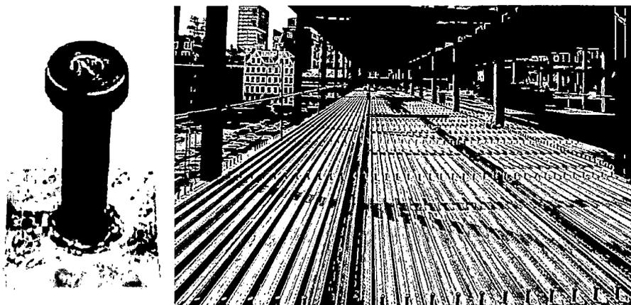
Figura N°3.14. Conector de perno
