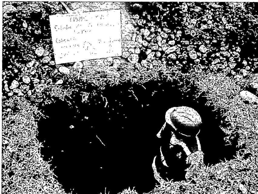
Foto 03. Ejecución de calicata C-6.
