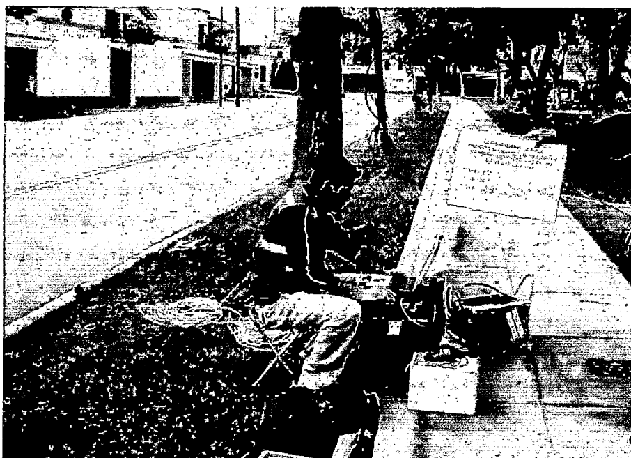
Foto 06. MASW-14, ubicado en la avenida Los Capulíes. Se observa instalado el equipo de adquisición de datos y el tendido de los cables para el registro de ondas.
