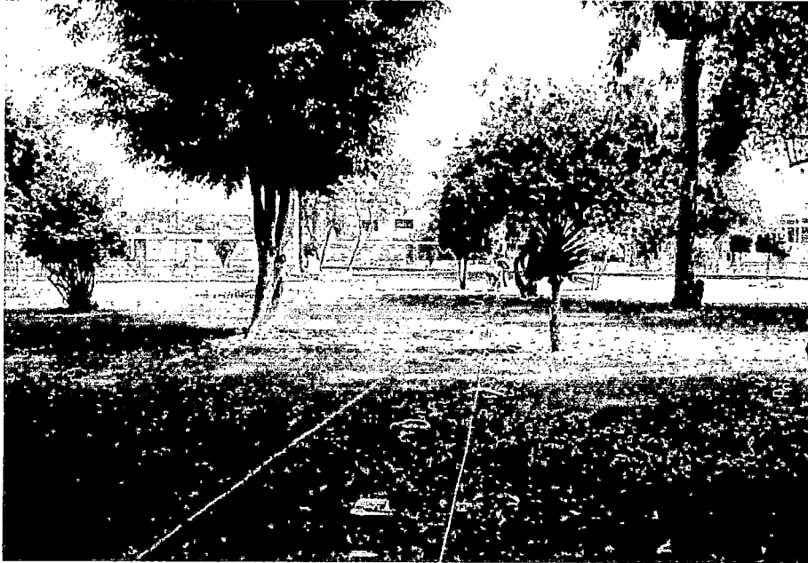
Foto 07. MASW-15, ubicado en el jirón Los Ficus. Se observa el tendido de los cables para el registro de ondas.
