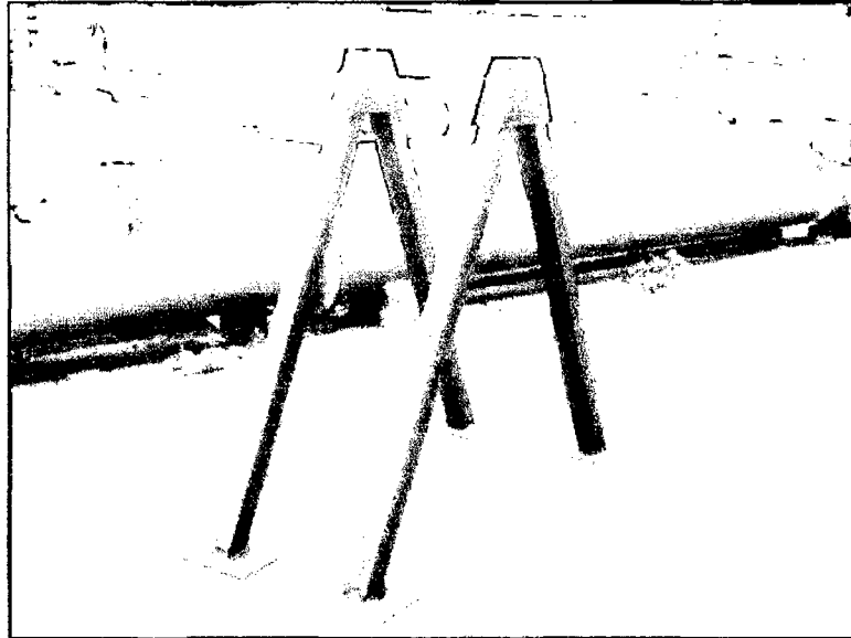
Foto 3.5. Tijerales que eventualmente constituirían la subestructura del modelo.
