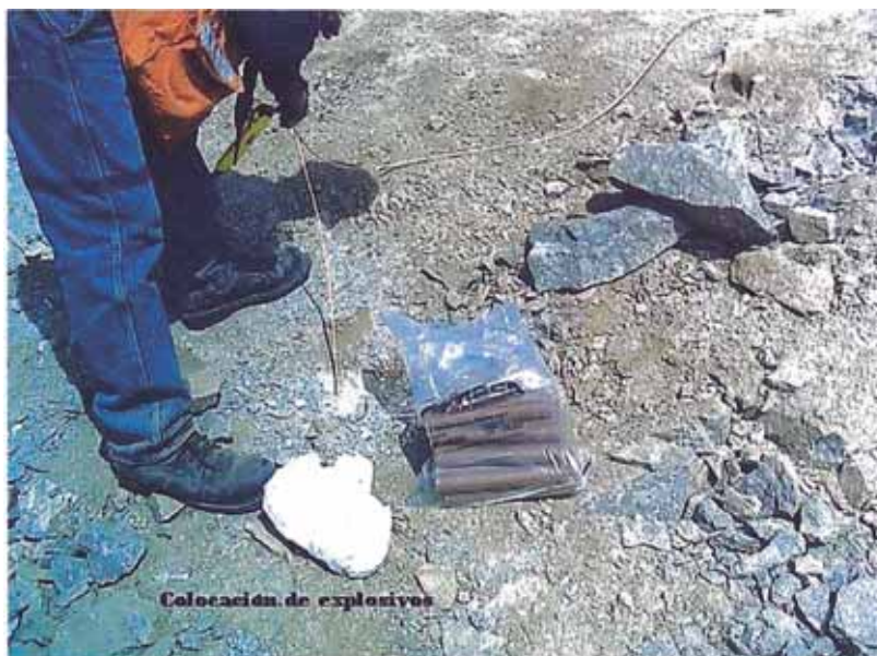
Foto 4.1: Colocación de explosivos en cantera.
