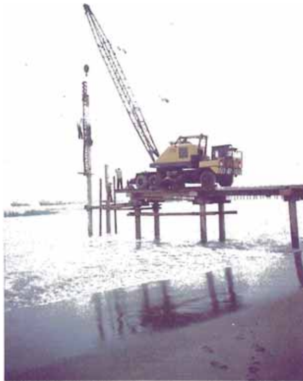
Foto 5.6: Hincado de pilotes verticales.
