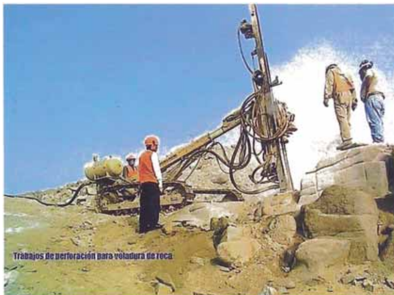
Foto 4.2: Trabajos de perforación para voladura de roca.
