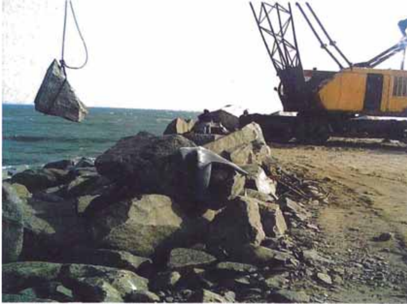
Foto 4.5: Colocación de roca en coronación.
