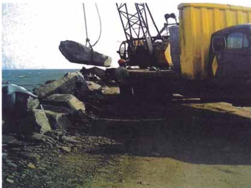
Foto 4.4: Colocación de roca en cuerpo de escollera. Fuente: Obra Construcción de la Segunda Prolongación el Molón de Salaverry – Terminal Portuario de Salaverry – ENAPU.
