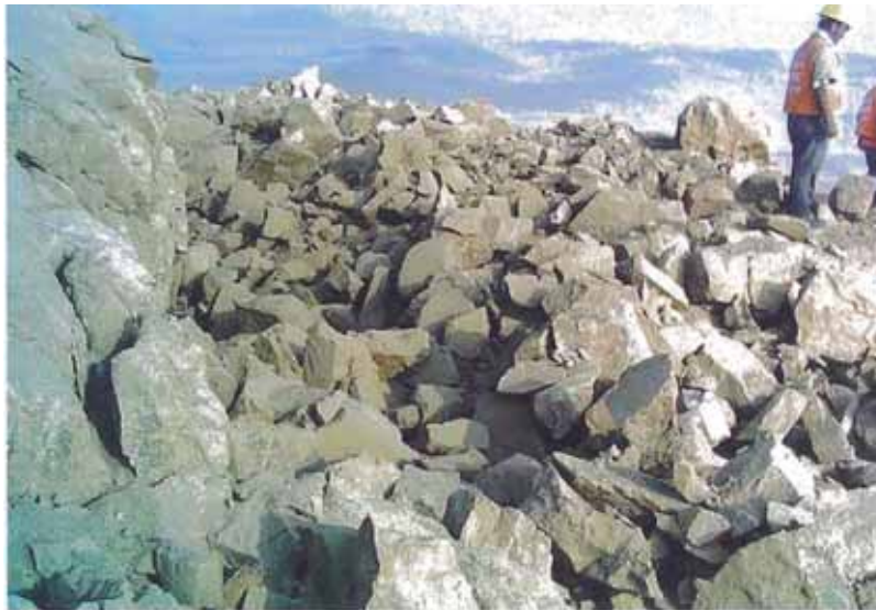
Foto 4.3: Vista de material obtenido de la voladura.
