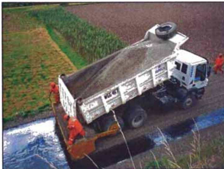
Figura N° 1.06: Tendido de gravilla mediante esparcidora en el Km. 255+400.
