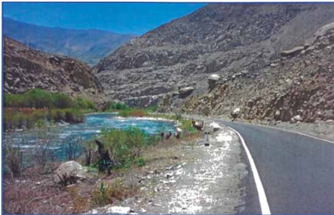
Figura N° 4.05: Tramo de carretera con peligro de inundación.
