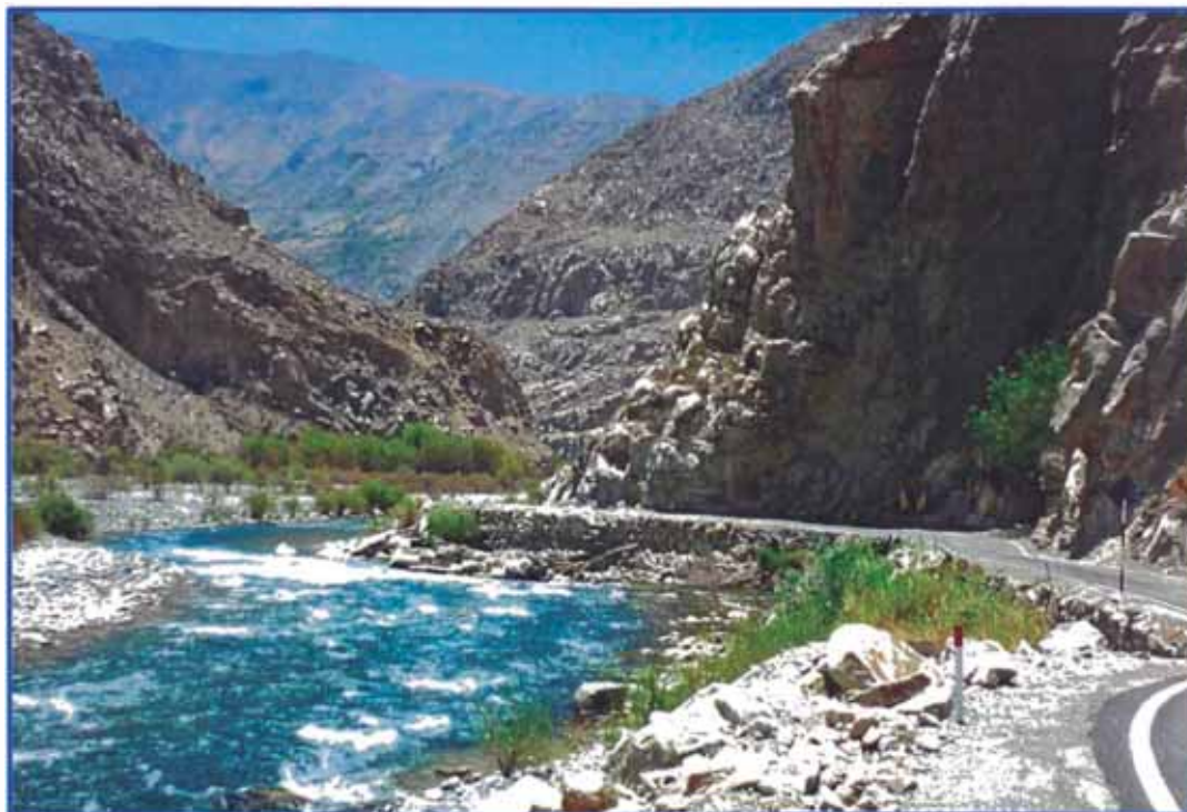
Figura N° 4.06: Tramo de carretera con peligros de erosión.
