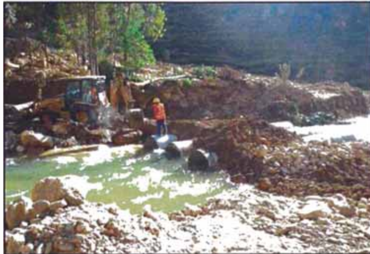
Figura N° 1.07: Atención de emergencia-Colocación de alcantarillas.
