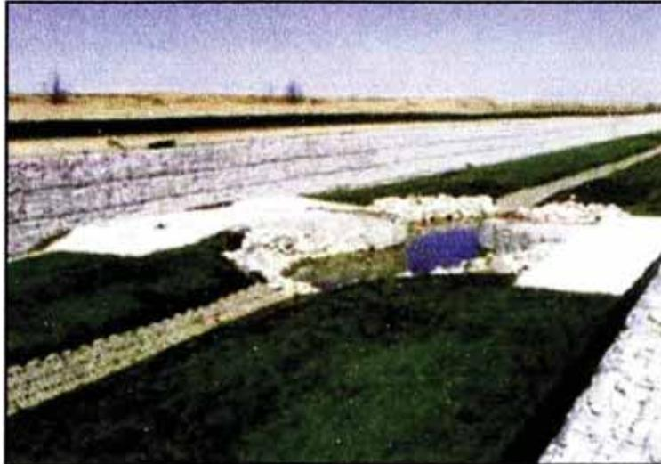
**Fig.5.3** Aplicación de los Gaviones en canalizaciones
