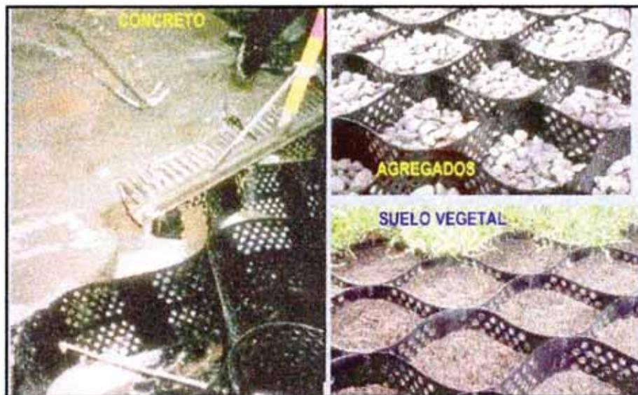
Fig. 5.17 El uso de la geocelda con relleno de diversos tipos de materiales.
