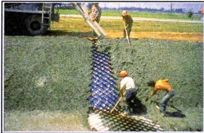
Fig.5.2 Utilización de las Geoceldas en el revestimiento de canales
