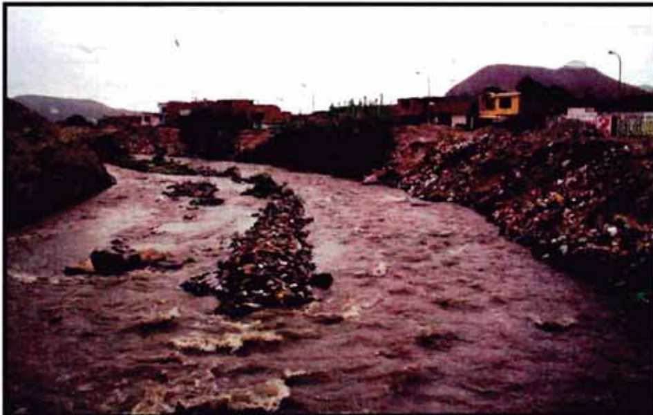
Se observa el dique con basura, lado del distrito de Puente Piedra. Diciembre de 2006.
