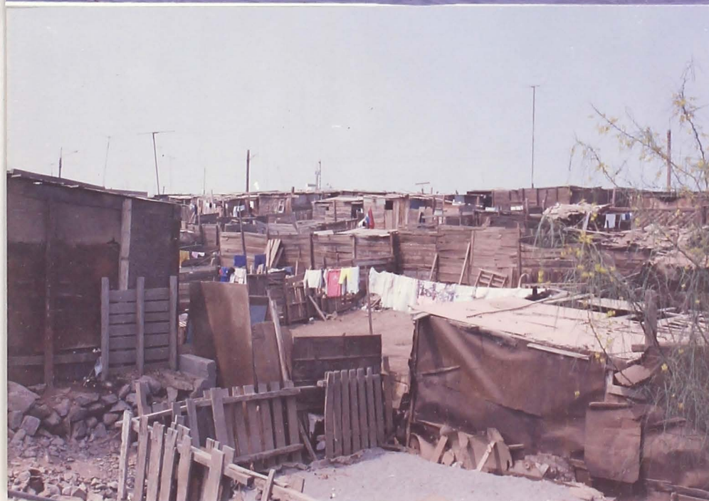
FOTO 7.3 Edificaciones TIPO 0 altamente vulnerables, la población vive en hacinamiento, acostumbran criar cerdos y aves en malas condiciones de higiene propiciando la proliferación de moscas y roedores.
