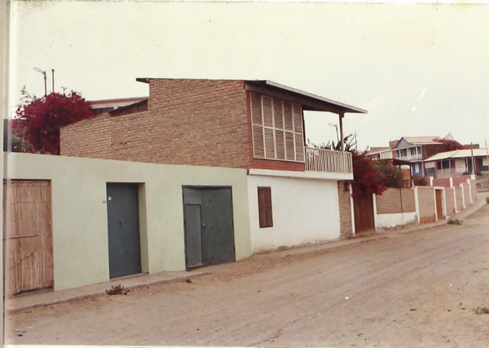
FOTO 5.4 Edificaciones tipo 2 de albañilería, nótese la ausencia de columnas y vigas y el techo ligero y flexible sin capacidad para distribuir esfuerzos horizontales
