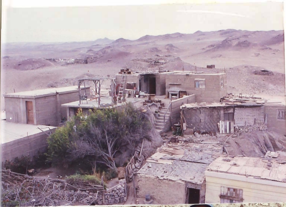
FOTO 6.4 Al fondo constr. con paredes de concreto sobre roca . Derecha: Construcciones de quin- cha-barro y esteras
