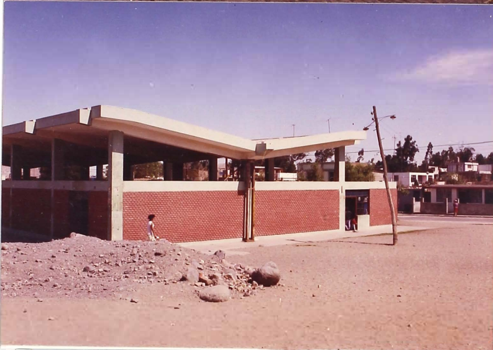
FOTO 9.25 El mercado "Ciudad Mi Trabajo", falla por "Co- lumna Corta" concen- tración de esfuerzos en la columna central de- bido al diseño del techo.
