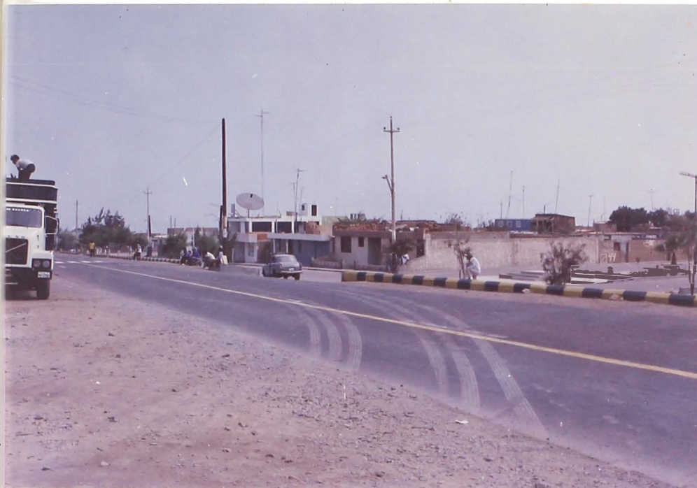
FOTO 7.1 Vista del pueblo tomada desde la Carretera Panamericana. Al lado derecho se ve el parque florida y al fondo el edificio de la municipalidad. Nótese las edificaciones tipo 1 (albañilería confinada).
