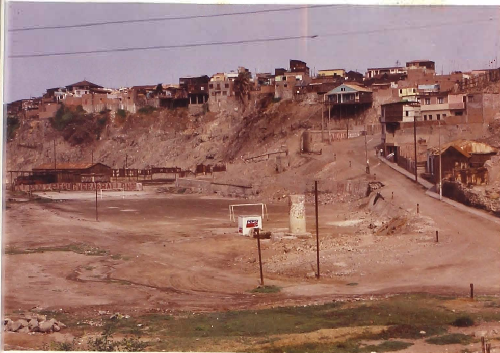
FOTO 9.2 Viviendas que han sido construidas al borde del acantilado, apoyados en esbeltos pilares de madera. Las paredes como los elementos de soporte están seriamente debilitados por la acción de la humedad y los insectos.
