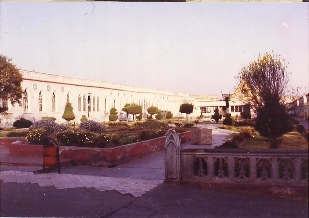
FOTO 9.18 Hospital Goyoneche de infraestructura antigua y dañada por sismos anteriores.
