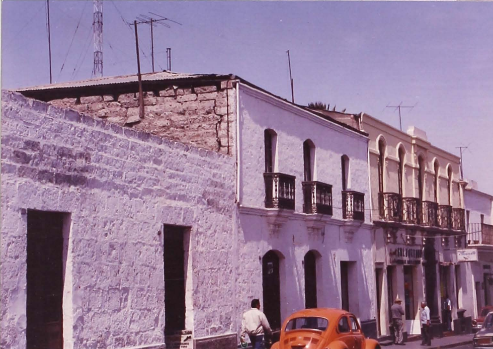
FOTO 9.22 En edificaciones de este tipo funcionan muchos colegios, academias y centros públicos. Tienen una antigüedad prome- dio entre los 50 y 100 años
