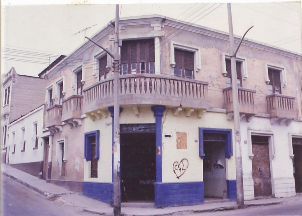
FOTO 9.5 Viviendas antiguas de paredes de concreto dañada por sismos anteriores, nótese la rajadura en el frontis.
