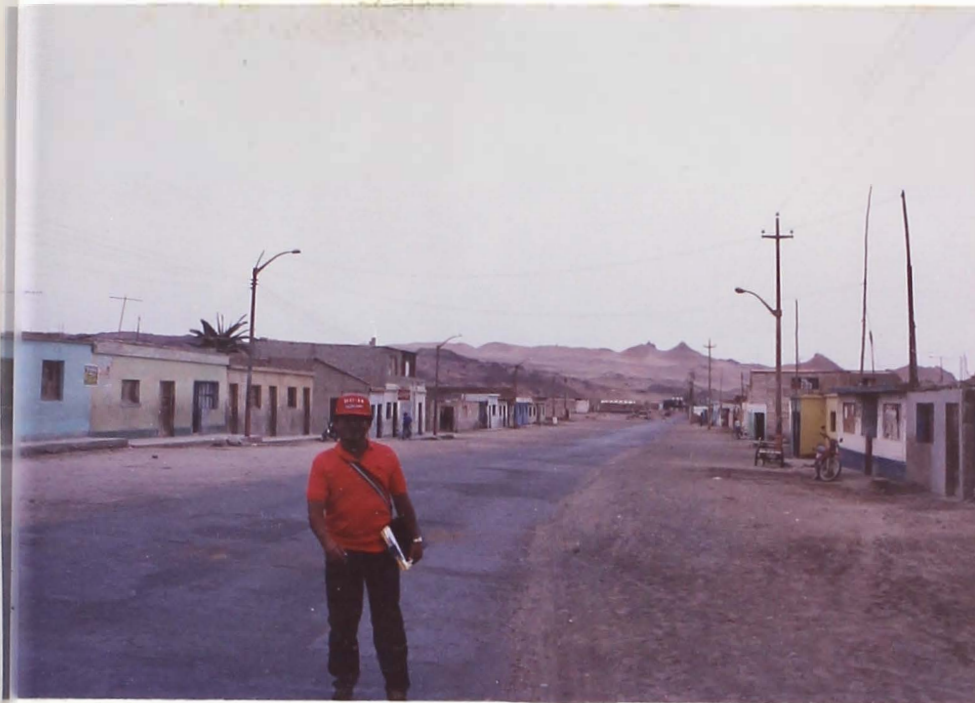
FOTO 6.1 Edificaciones con paredes de concreto y albañilería confinada (Chala nueva)
