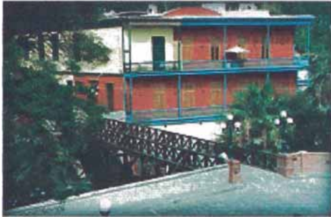
Puente de Los Suspiros (vista 1)
