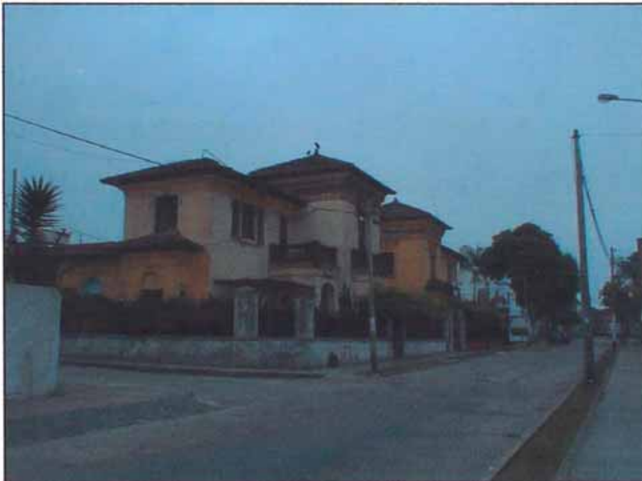
Aquí apreciamos esta casona antigua de comienzos del siglo XX ubicada en la esquina de los jirones Zegarra de Pinillos y Tacna, es de adobe, encontrándose en regular estado de conservación, además es de 2 niveles, lo cual incrementa su vulnerabilidad ante un sismo; como éstas se encuentran varias en el sector 3.
