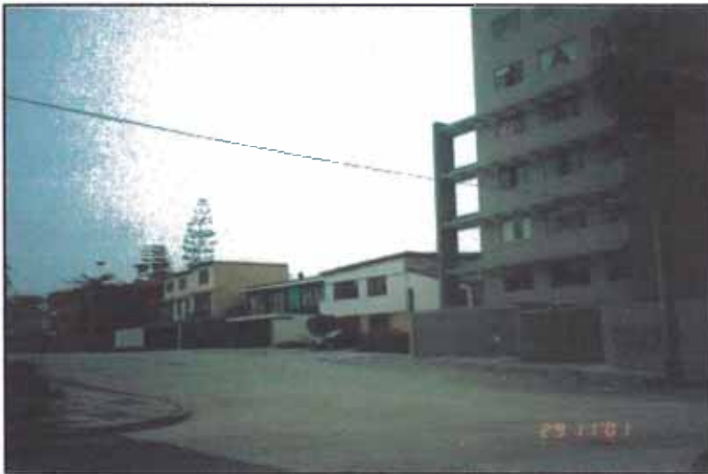
Imagen de la Av. El Sol Oeste, representativa de la zona 1; podemos apreciar edificaciones de C.A. y Albañilería en buen estado de conservación, de poca antigüedad.
