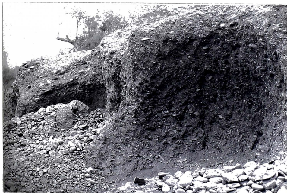
FOTO N°3-A.- Vista del perfil estratigráfico del suelo - en la cercanía de la planta de tratamiento de desague. Obsérvese la grava de formación angular y de mala graduación, que es empleada en el enrocado de la planta- Octubre 1974.
