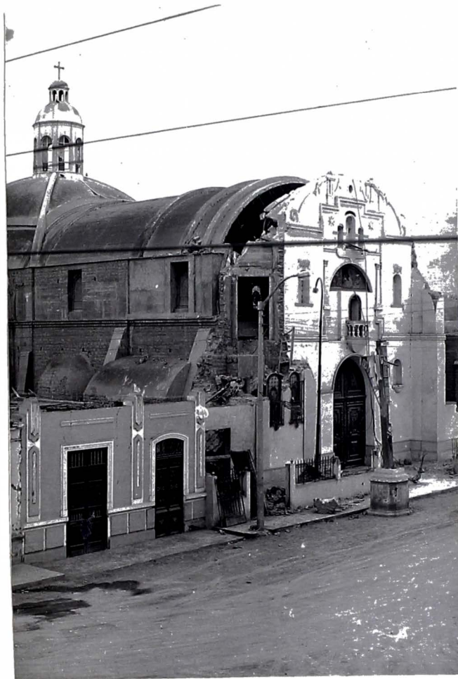
FOTO N°9.- Vista de la elevación principal de la Iglesia de Santa Cruz de Flores, después del sismo del - 3 de Octubre de 1974.
