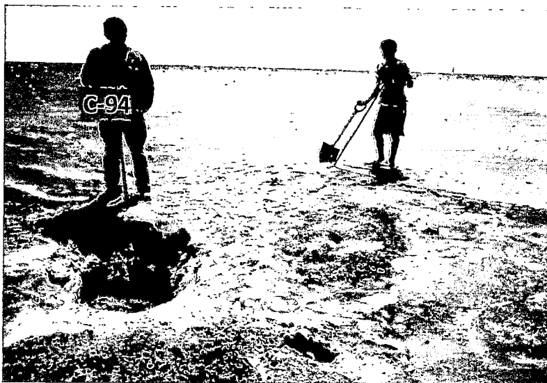
Foto 186: Calicata C-94, ubicada en la reserva de Paracas, frente a la vía de acceso hacia el Puerto General San Martín . Ver Plano P-01.
