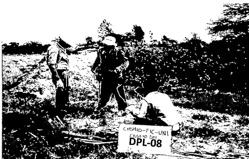
Foto 8: Ensayo DPL-08. Realizado cerca a la calicata C-65, hasta una profundidad de 1.90 m. Se observa el equipo instalado y al equipo técnico ejecutando el ensayo mediante golpes. Ver Plano P-01.
