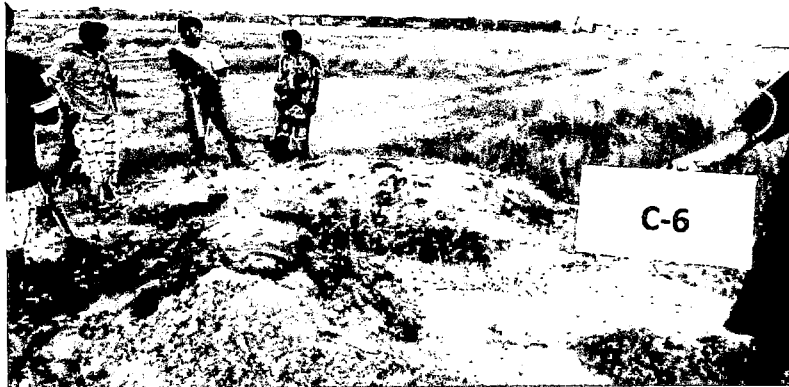
Foto 11: Calicata C-6, ubicada al oeste del AA. HH. Pozuelo, cerca de la playa, en el sector norte del área en estudio. Ver Plano P-01.
