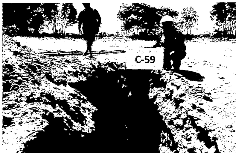
Foto 118: En la calicata C-59, de 0.00 a 0.40 m se observa grava limosa (GM); de 0.40 a 1.30 m, grava bien gradada con arena (GW); de 1.30 a 2.50 m se tiene arena mal gradada (SP) de compacidad densa a muy densa.
