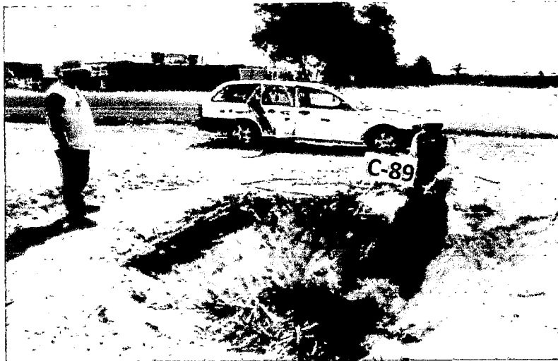
Foto 177: Calicata C-89, ubicada al sur del distrito de San Andrés, al lado de la Panamericana Sur, frente al "Huerto Alamein". Ver Plano P-01.
