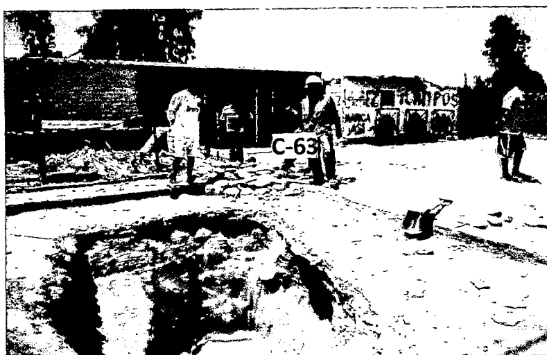
Foto 125: Calicata C-63, ubicada en San Andrés. Ver Plano P-01.
