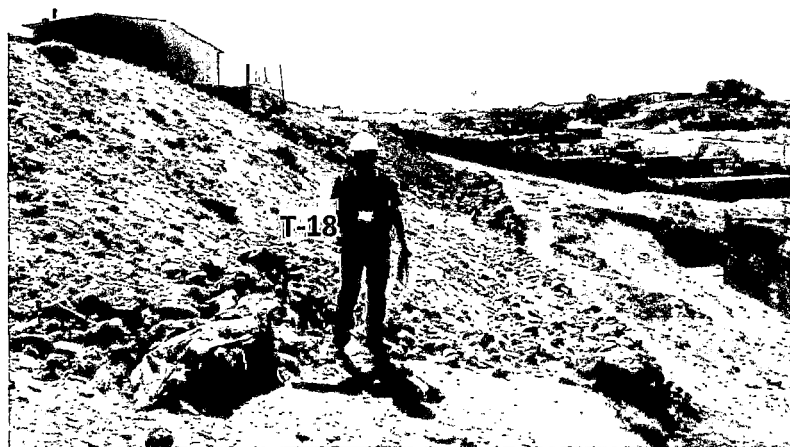
Foto 36: En el talud T-18, de 0.00 a 4.00 m se tiene relleno contaminado.
