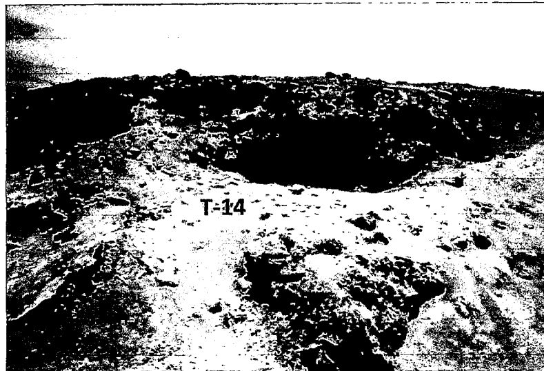
Foto 28: En el talud T-14, de 0.00 a 2.00 m se observa arena fina a media, suelta, presencia de grava.
