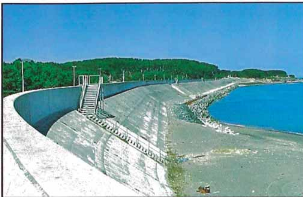
Figura 41. Muro de protección ante tsunamis (CISMID, 2012).
