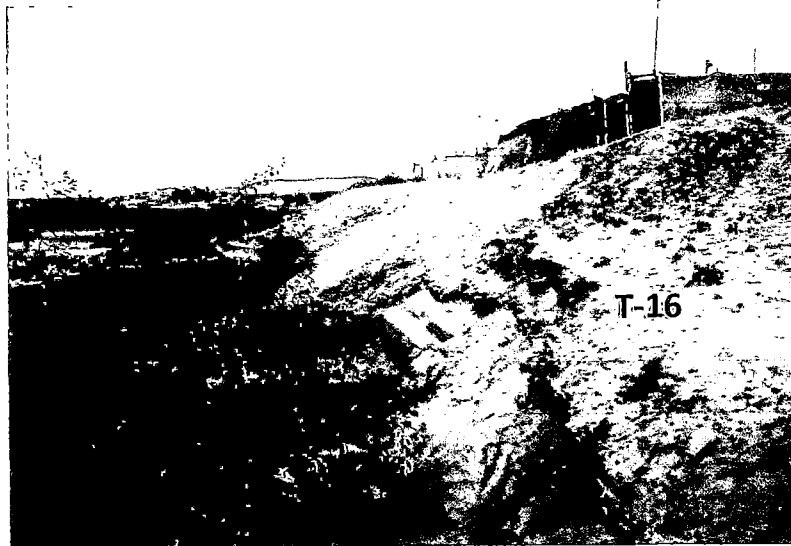
Foto 31: Talud T-16, ubicado en el distrito de San Clemente, a 250 m de la Panamerica sur. Ver Plano P-01.
