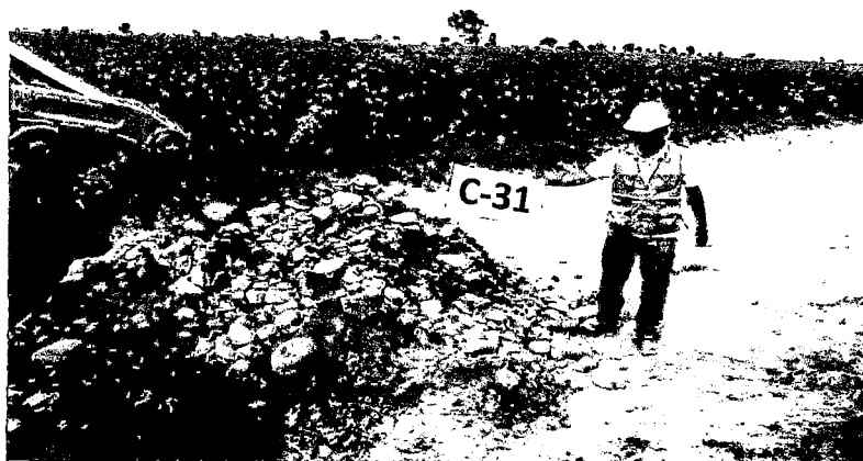
Foto 61: Calicata C-31, ubicada al suroeste del distrito de San Clemente y al norte del río Pisco. Esta calicata se encuentra en áreas de terreno de cultivos. Ver Plano P-01.
