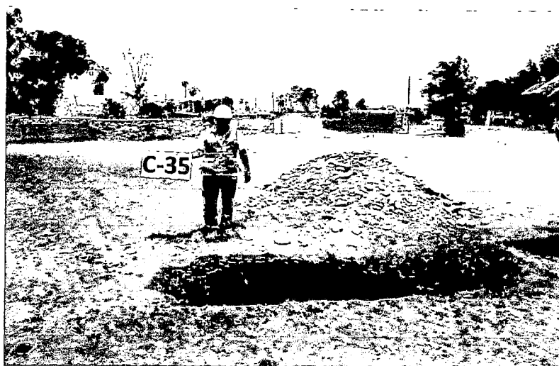
Foto 69: Calicata C-35, ubicada en el distrito de San Clemente y al norte del río Pisco. Ver Plano P-01.
