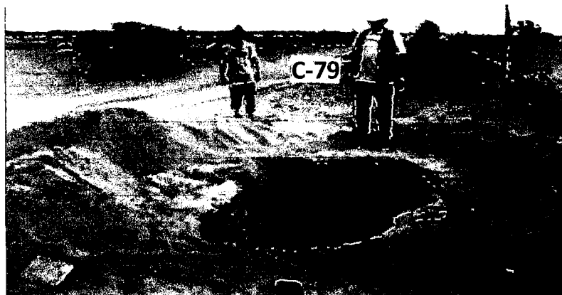
Foto 157: Calicata C-79, ubicada al oeste de la Panamericana Sur, al sur de la Planta Corporación Aceros Arequipa. Ver Plano P-01.
