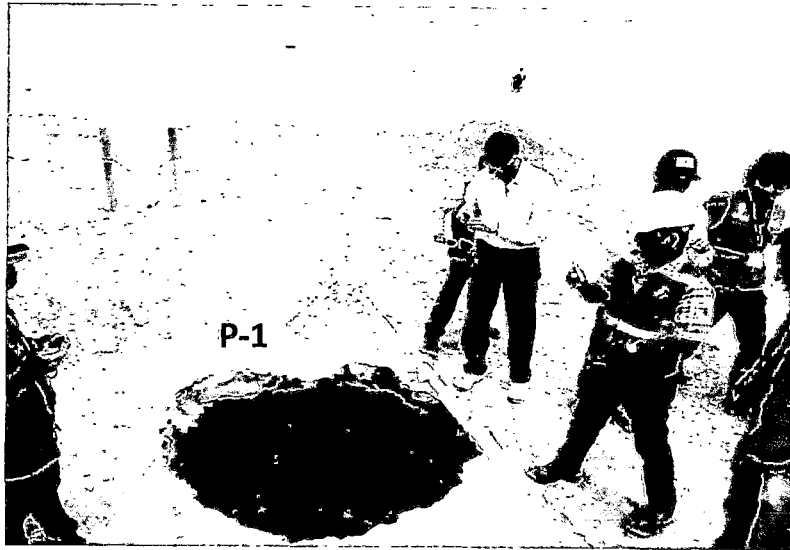
Foto 45: Pozo P-1, ubicado en el distrito de San Clemente, cerca a la Panamericana Sur. Ver Plano P-01.
