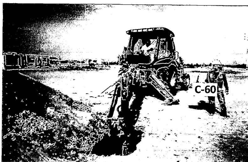
Foto 119: Calicata C-60, ubicada al suroeste de Villa Túpac Amaru Inca. Ver Plano P-01.
