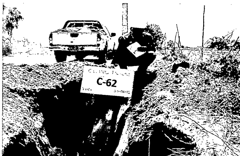
Foto 124: En la calicata C-62, de 0.00 a 0.10 m se observa material de relleno contaminado; de 0.10 a 1.80, arena mal gradada (SP) de compactación muy suelta.
