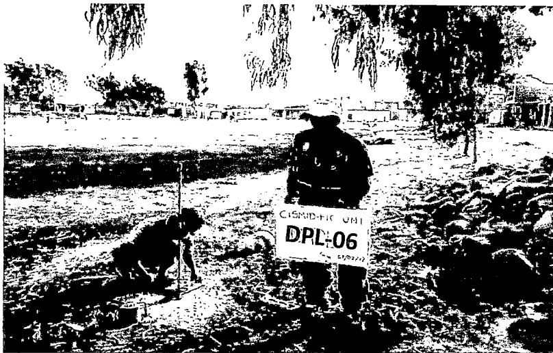
Foto 6: Ensayo DPL-06. Realizado cerca a la calicata C-38, hasta una profundidad de 3.60 m. Se observa el equipo instalado y al equipo técnico ejecutando el ensayo mediante golpes. Ver Plano P-01.
