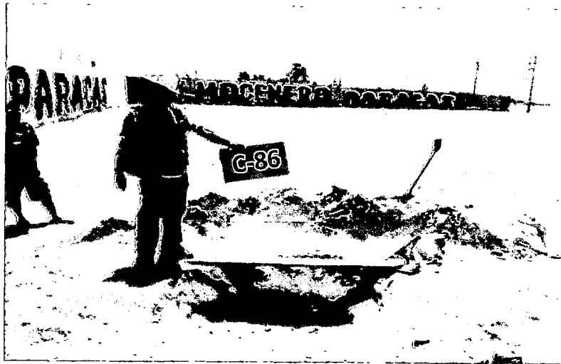
Foto 171: Calicata C-86, ubicada en la entrada de la almacenera Paracas, al sur del distrito de Paracas. Ver Plano P-01.
