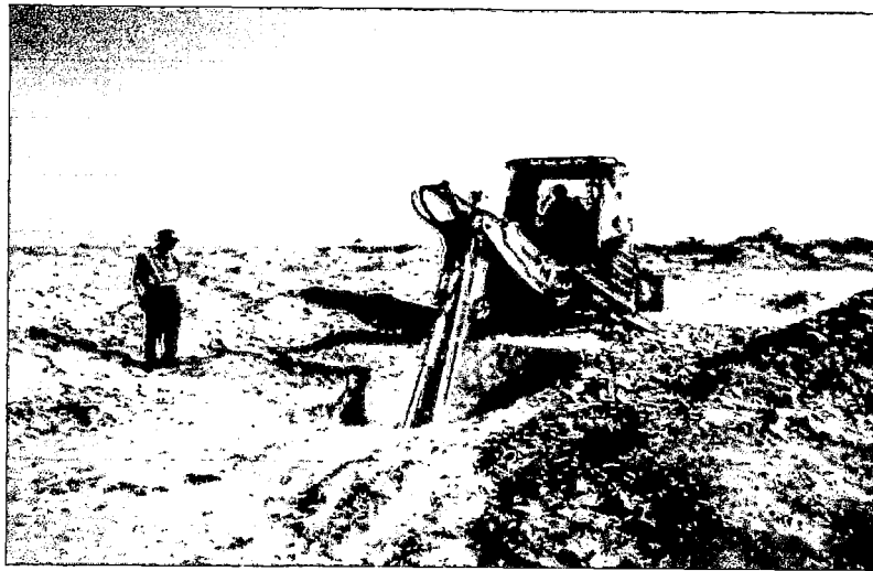
Foto 151: Calicata C-76, ubicada al norte de Paracas, cercano al litoral marino. Ver Plano P-01.
