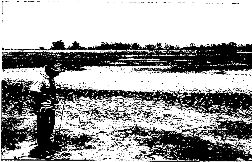
Foto 5: Ensayo DPL-05. Realizado en la zona de humedales hasta una profundidad de 2.00 m. Se observa el equipo instalado y al equipo técnico ejecutando el ensayo mediante golpes. Ver Plano P-01.
