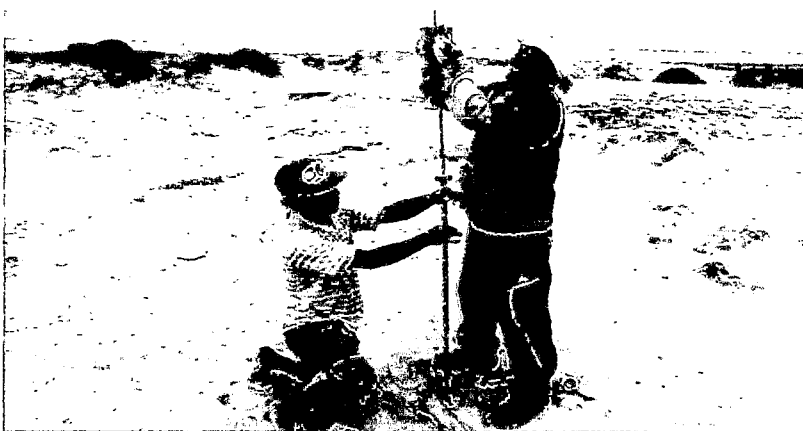
Foto 2: Ensayo DPL-02. Realizado en la zona de humedales en el distrito de San Clemente hasta una profundidad de 2.60 m. Se observa el equipo instalado y al equipo técnico ejecutando el ensayo mediante golpes. Ver Plano P-01.
