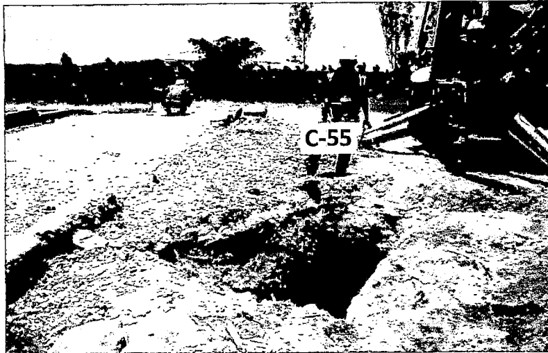
Foto 109: Calicata C-55, ubicada al noroeste de Villa Tupac Amaru Inca y al sur del río Pisco. Ver Plano P-01.
