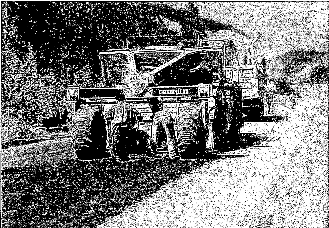
TREN DE LA RECUPERACIÓN, SEGUNDO SEGMENTO RECUPERADO, PERSONAL ASISTIENDO CONTROL DE GRADACIÓN, EL CUAL DEBERA SER MAX DE 2" , LOS QUE SOBREPASEN SERAN ELIMINADOS MANUALMENTE, PROFUNDIDAD Y POSTERIOR CAMBIO DE BITS
