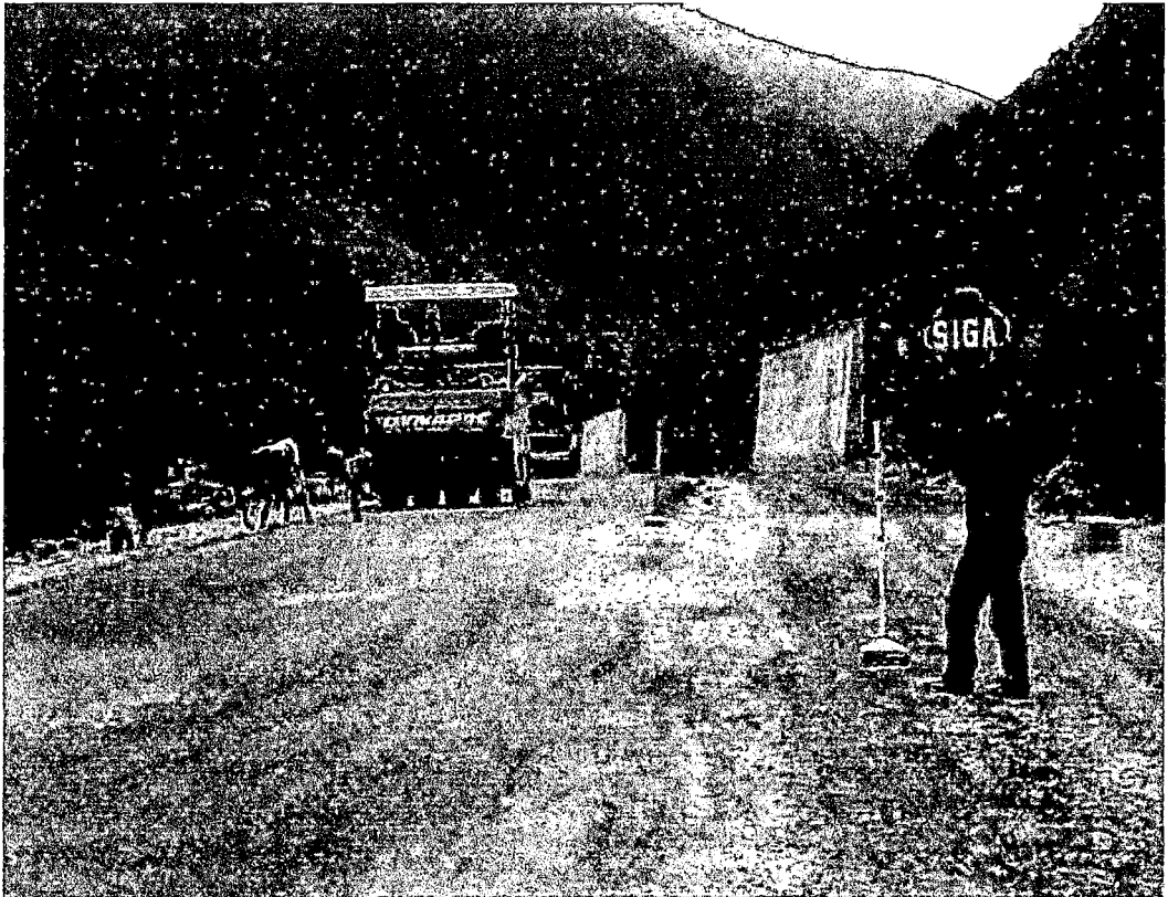
COMPACTACION DE SUB BASE ; RACIONALIZANDO EL TRAFICO
