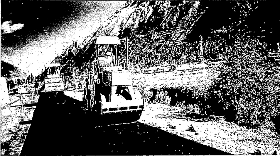
RODILLO TÁNDEM INGRESANDO EN TRAMO RECTO SEGUIDO POR EL RODILLO NEUMÁTICO,
