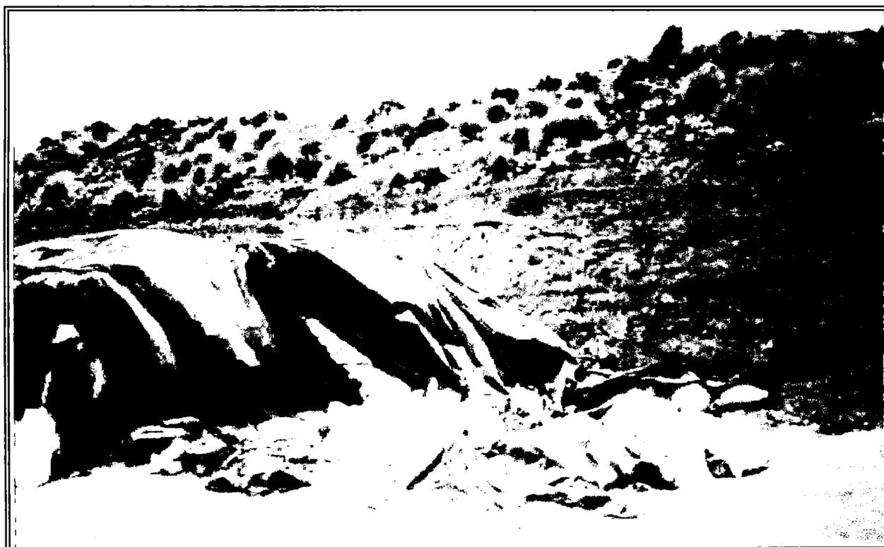
*Bolsas de cal hidratada debidamente protegidas para evitar el contacto con la humedad.*
