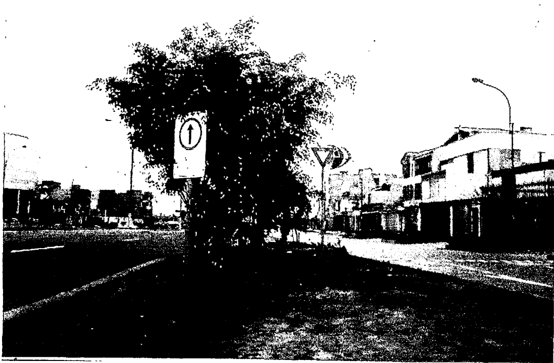
SEÑALES VERTICALES AL INICIO DE LA VIA EXPRESA ( INTERCAMBIO VIAL SUR) MAL UBICADAS Y CON ARBUSTOS QUE OBSTACULIZAN SU BUENA VISION, EVIDENCIANDO UNA FALTA DE MANTENIMIENTO A POCOS DIAS DE SU INAUGURACIÓN. (SENTIDO ESTE – OESTE) FOTO Nº 77
