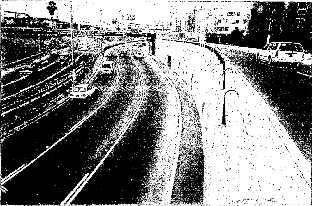
USO INCORRECTO DE LAS TACHAS. NÓTESE LA INVASIÓN DE CARRILES POR VEHÍCULOS EN CURVA PELIGROSA. (SENTIDO ESTE- OESTE) FOTO Nº 91
