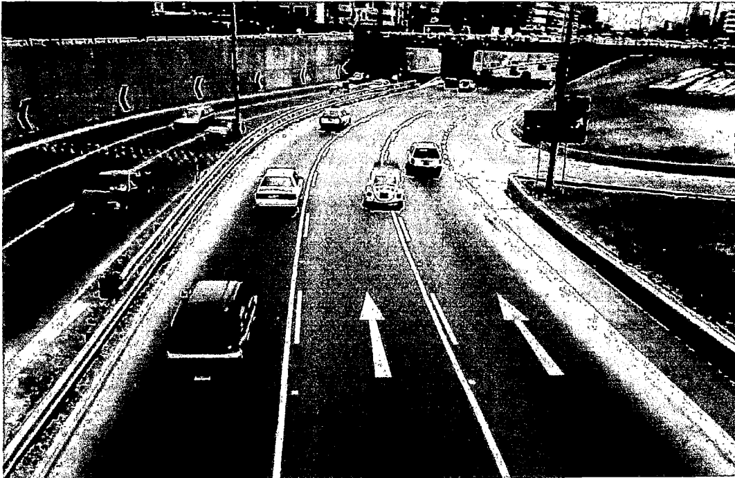
INVASIÓN DE CARRILES EN CURVA PELIGROSA . NOTESE TRAMOS DE GUARDAVÍA SIN PINTAR , EN EL SEPARADOR CENTRAL. (SENTIDO OESTE - ESTE) FOTO Nº 90
