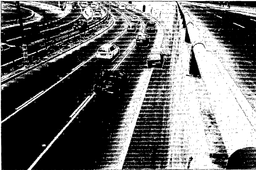
TRAMO EN CURVA SIN SOBREALCHO, PASANDO EL PUENTE SAN LUIS. NOTESE AUTO MALGRADO OCUPANDO PARTE DE LA BERMA Y DEL CARRIL DERECHO DE LA CALZADA. (SENTIDO ESTE - OESTE) FOTO Nº 26
