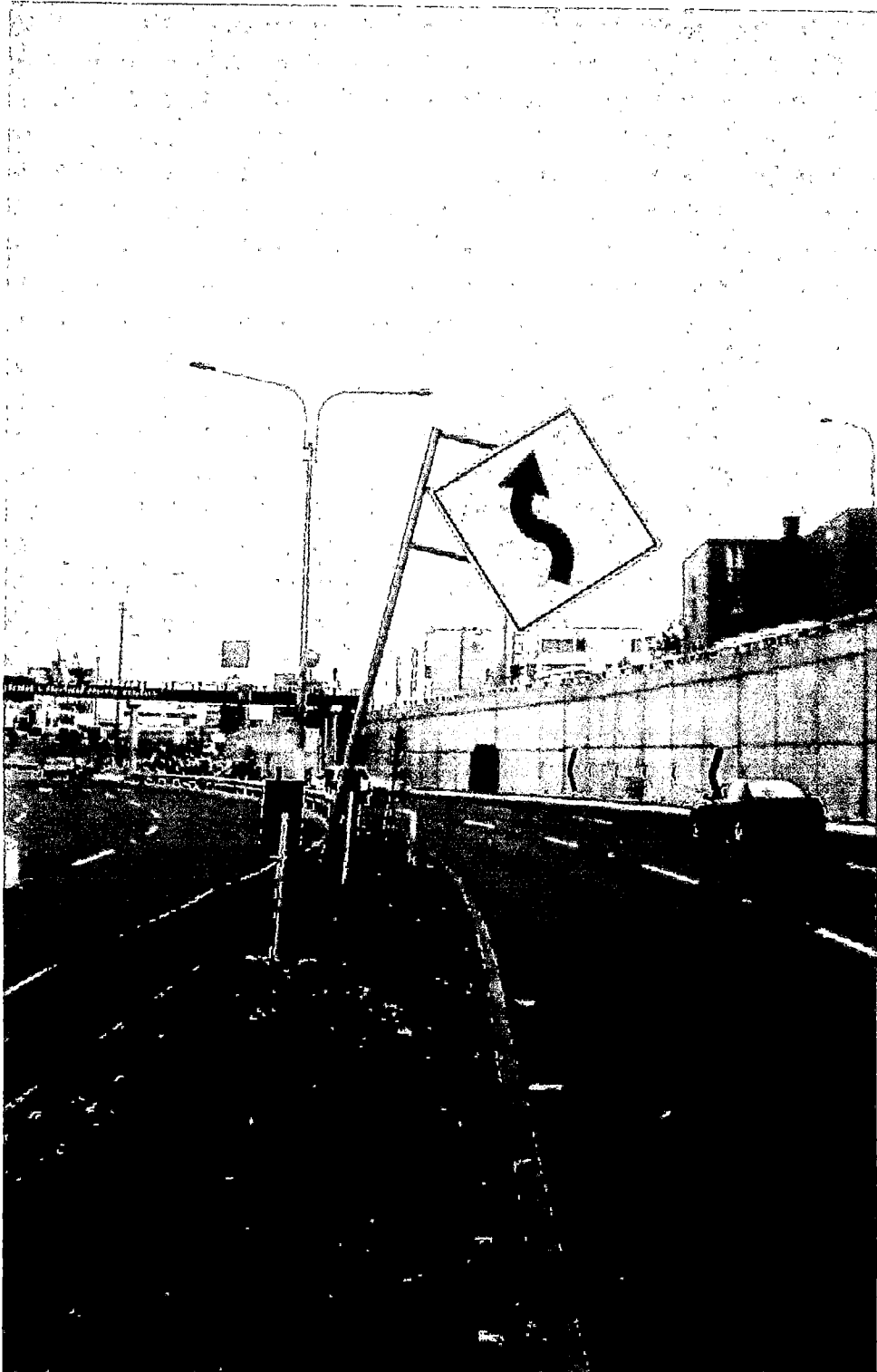
SEÑAL DE CURVA PELIGROSA DESCUIDADA, EN TRAMO DE LA MUERTE. NÓTESE RESTOS DE ASFALTO EN LA BERMA SEPARADORA. (SENTIDO ESTE - OESTE) FOTO Nº 54
