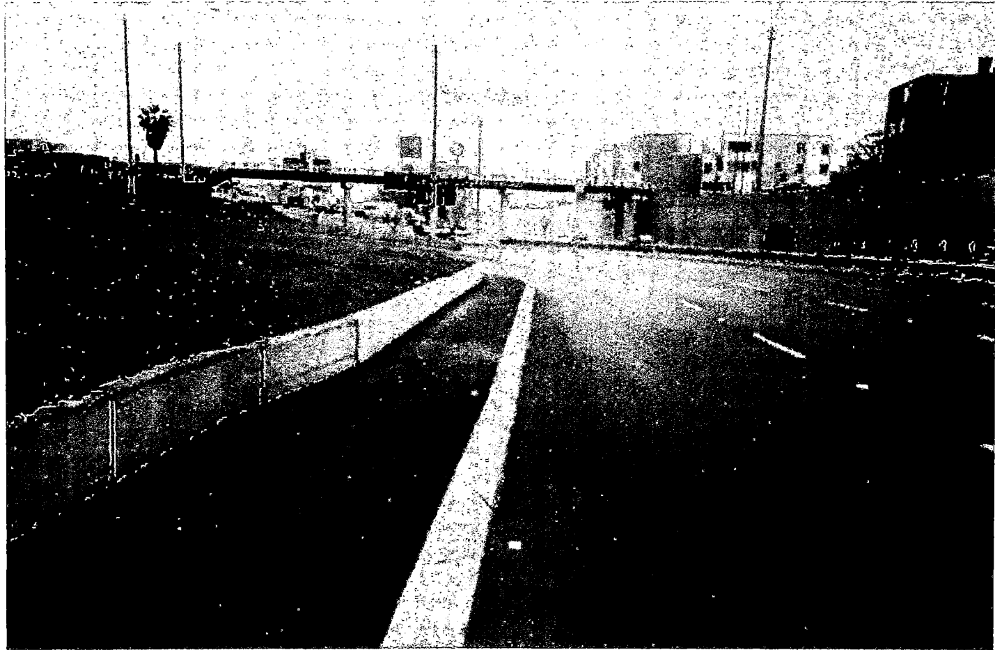
OTRA VISTA DE LA CURVA CERRADA EN EL TRAMO PELIGROSO ENTRE EL PUENTE PEATONAL Y EL PUENTE SAN LUIS. SE OBSERVA LA POBRE SEÑALIZACIÓN Y LA DEFICIENTE CONSTRUCCIÓN DE LA BERMA Y EL ACABADO DEL MURETE DE CONTENCIÓN DEL AREA VERDE DE LA OREJA (SENTIDO OESTE - ESTE) FOTO Nº 48
