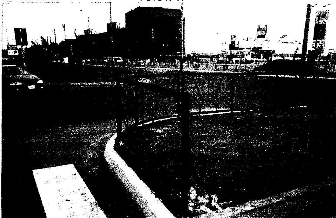
REJA DE SEGURIDAD EN MAL ESTADO – FRENTE A BERMA CENTRAL DE PUNTE AVIACIÓN. PINTURA DE PASO PEATONAL MAL UBICADO Y BORRANDOSE (SENTIDO NORTE – SUR) FOTO Nº 80
