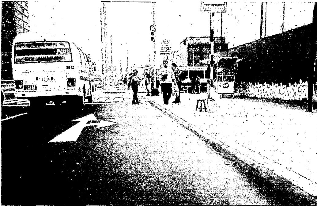
PARADERO DE TRANSPORTE PUBLICO SIN DEMARCAACION EN LA CALZADA. FLECHA DE CARRIL VEHICULAR INDICA QUE PUEDE CIRCULAR DE FRENTE CON LA POSIBILIDAD DE IMPACTAR CONTRA POSTE DE LUZ INSTALADO DENTRO DE LA VEREDA CONSTRUIDA EN LA PROYECCIÓN DEL CARRIL VEHICULAR (SENTIDO NORTE - SUR) FOTO N° 67
