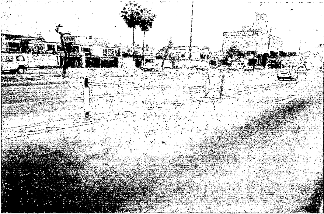
DISPOSITIVOS DE SEGURIDAD INADECUADOS AL INICIO DE LA VIA EXPRESA (DESPUES DEL INTERCAMBIO VIAL SUR). OBSERVESE QUE LAS SEÑALES HORIZONTALES EN LA CALZADA NO HAN SIDO RETOCADAS Y QUE LA SUPERFICIE DE RODADURA DE LA VIA LATERAL ESTA DETERIORADA (SENTIDO ESTE - OESTE) FOTO N° 73
