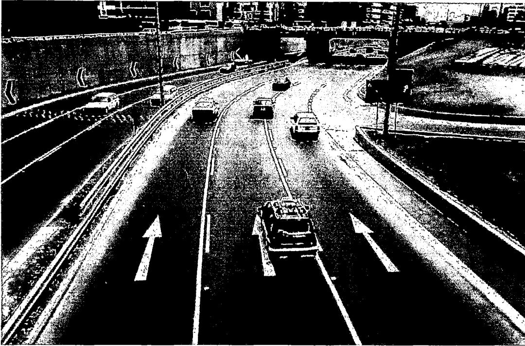
INVASIÓN DE CARRILES EN CURVA PELIGROSA. NOTESE TRAMOS DE GUARDAVÍAS EN SEPARADOR CENTRAL SIN PINTAR (SENTIDO OESTE - ESTE) FOTO Nº 89
