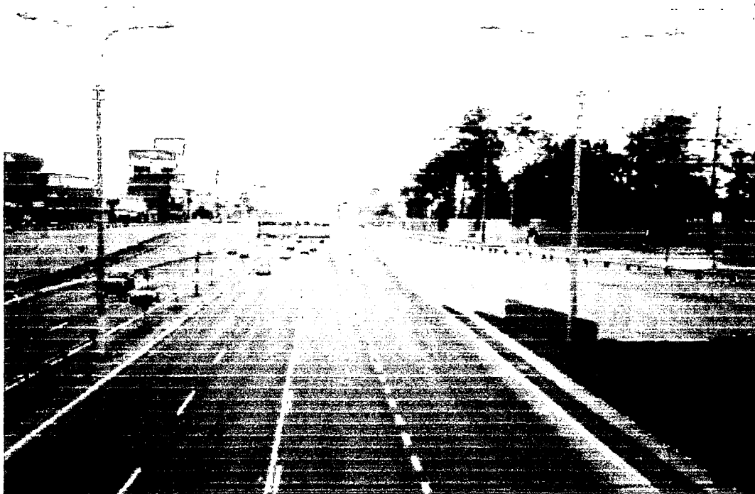
VISTA PANORAMICA DE LA VIA RAPIDA, SECTOR AV. AVIACION – PUENTE GUARDIA CIVIL, OBSERVESE LA FALTA DE BERMAS PARA ESTACIONAMIENTO DE EMERGENCIA (SENTIDO ESTE – OESTE) FOTO N° 07
