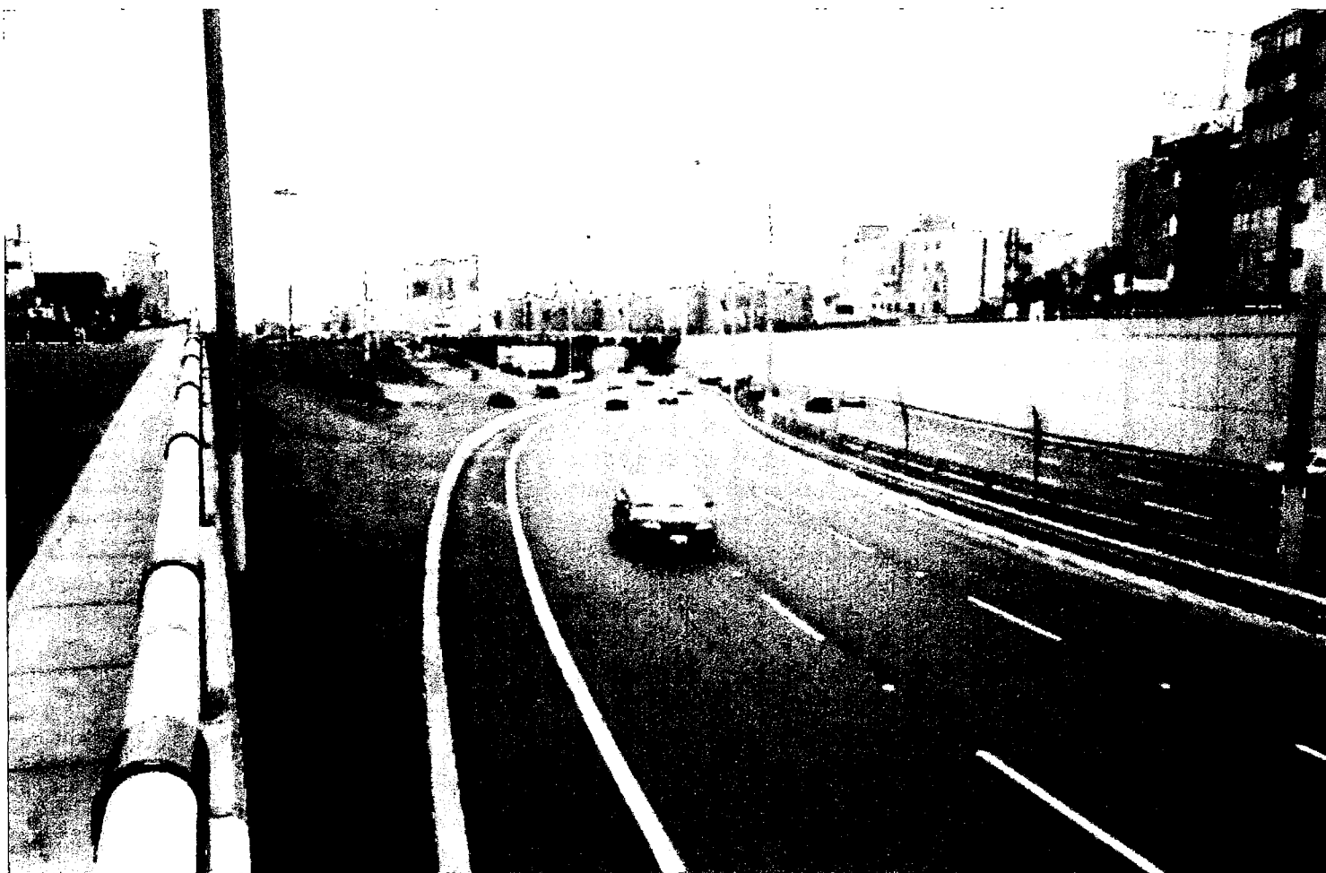
CURVA PRONUNCIADA DESPUÉS DE ATRAVESAR EL PUENTE SAN LUIS. NOTESE LA FALTA DE SEÑALIZACIÓN Y LOS TRABAJOS DE MOVIMIENTO DE TIERRAS LUEGO DE LA INAUGURACIÓN DE LA VIA.
