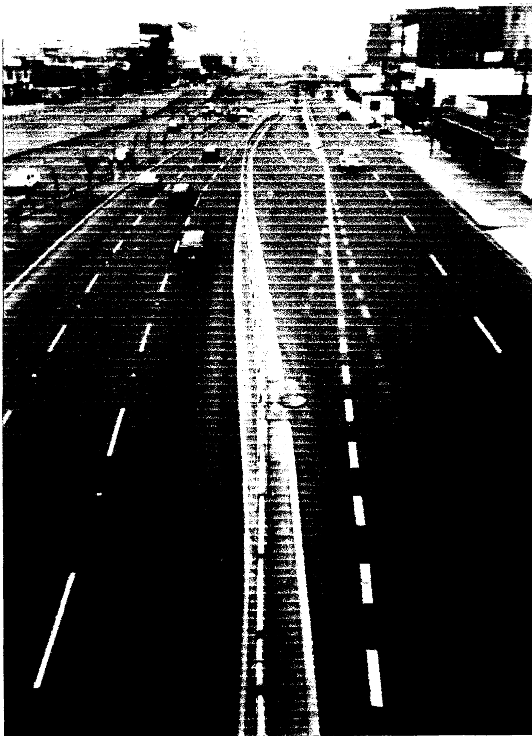
FALTA UNIFORMIDAD EN LA SECCIÓN DE LA VÍA. NÓTESE EL BORRADO Y DEMARCACIÓN EN LA CALZADA, DEFECTUOSOS. (SENTIDO ESTE - OESTE) FOTO N° 23
