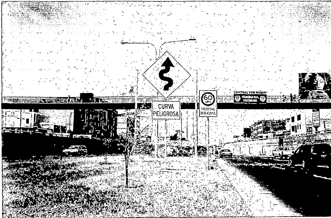
PILARES CENTRALES DEL PUENTE PEATONAL, EN LA ACTUALIDAD. NÓTESE LAS SEÑALES , LAS "TACHAS" EN LA CALZADA Y EL RECUBRIMIENTO DE LOS PILARES CON MONTÍCULOS DE TIERRA . (SENTIDO ESTE - OESTE) FOTO N° 37
