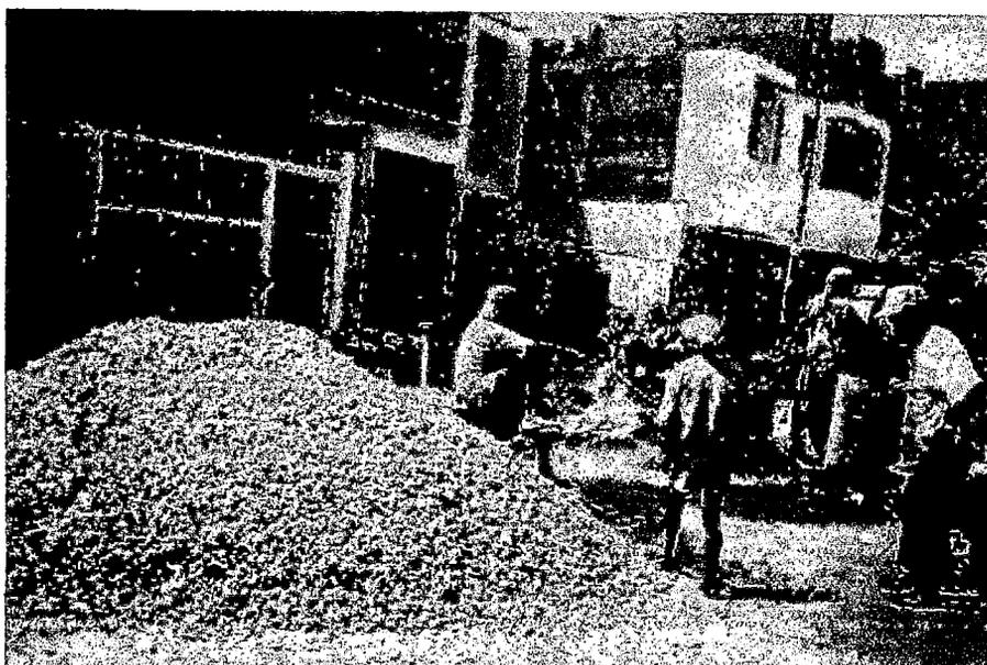
Foto A6.52 Como ocurre en todas las viviendas, la fabricación del concreto lo realizan en la vía pública, los agregados sobrantes quedan depositados en la calle.
