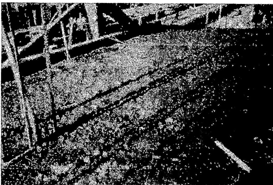
**Foto A6.48** Muestra una de las propiedades del concreto fresco, la exudación. La mezcla no es regular.
