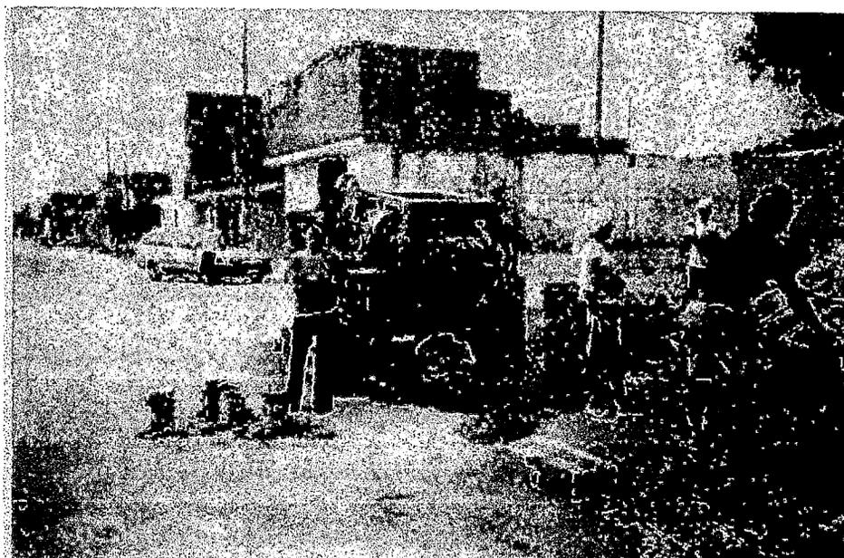
Foto A6.2 Para la fabricación del concreto se utilizó una mezcladora tipo tolva, se tomaron 4 muestras de concreto en moldes .
