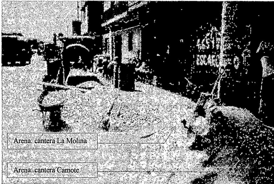
**Foto A6.19** La preparación de concreto en obra genera mayor tiempo; si tomamos como ejemplo esta obra podríamos citar unos de los inconvenientes presentados; en el proceso de fabricación el contratista calculó menor volumen de agregado, por lo que se tuvo que solicitar un pedido adicional de agregado fino dejando paralizado el proceso de fabricación y vaciado de concreto.
