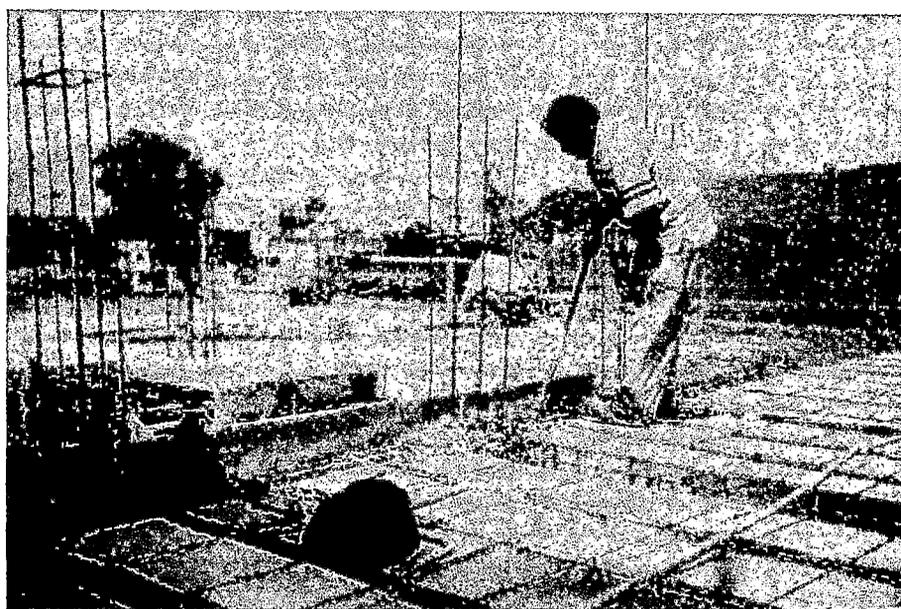
Foto A6.18 El constructor esta chuceando el concreto colocado en las vigas con un elemento de madera.
