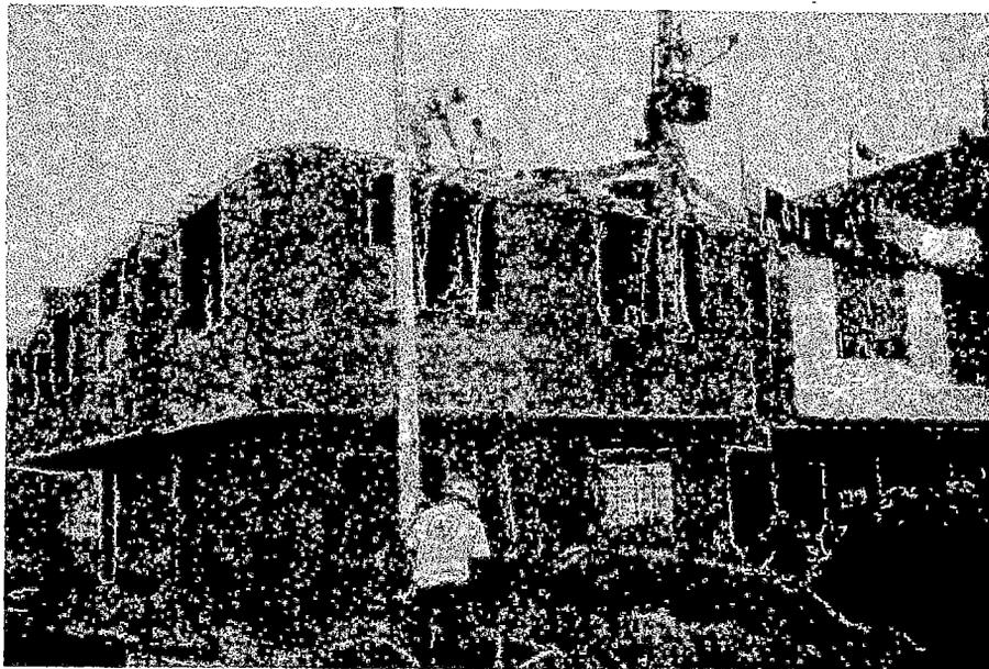
**Foto A6.13** En esta vivienda se transporto el concreto con ayuda de winche. El concreto fue recibido y transportado por carretillas. También cabe notar las irregularidades en altura y la falta de columnas en las esquinas.
