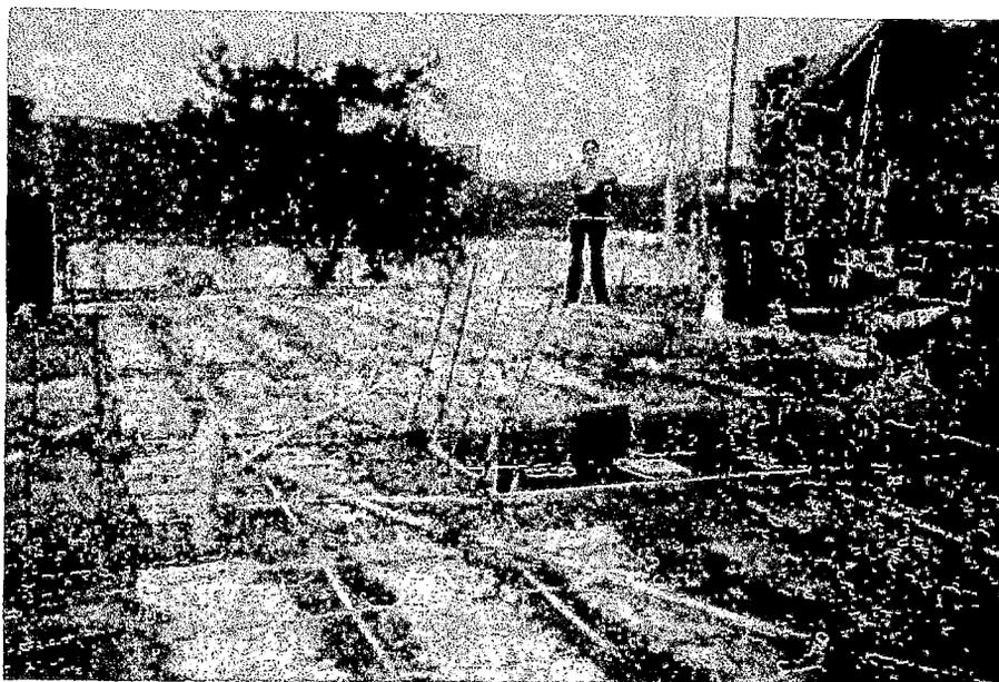
Foto A6.1 Vista panorámica del techo aligerado. El concreto fue colocado en dos etapas; primero las vigas y viguetas, segundo la losa con diferente dosificación.
