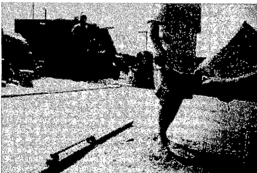
**Foto A6.31** Compactado del concreto, en la losa ya no lo chusean con la varilla lo reglean.
