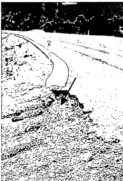
Foto 2.1 No Adecuada Entrega del Flujo de la Cuneta hacia Terreno Natural.
