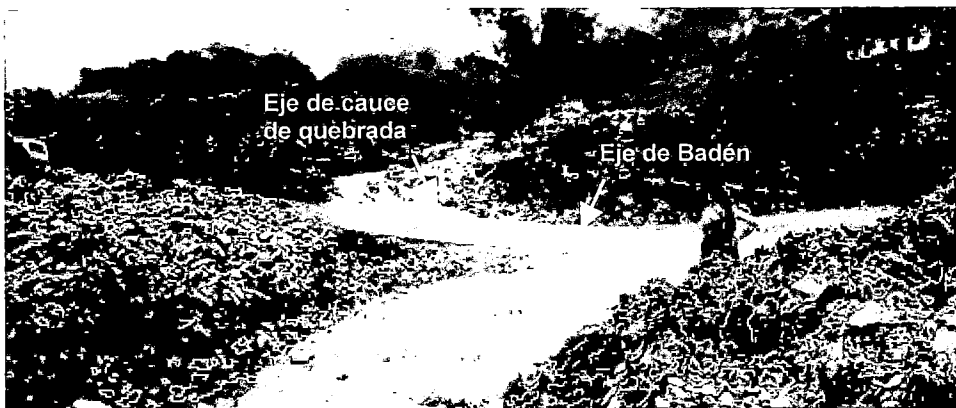
Foto 6.10 Vista hacia aguas arriba del Badén del Km. 74+359 de la Carretera Lima – Canta, se observa cambio de dirección del flujo proveniente de la quebrada cuando llega al Badén, también se observa que el flujo del Badén llega al canal natural de canto rodado.
