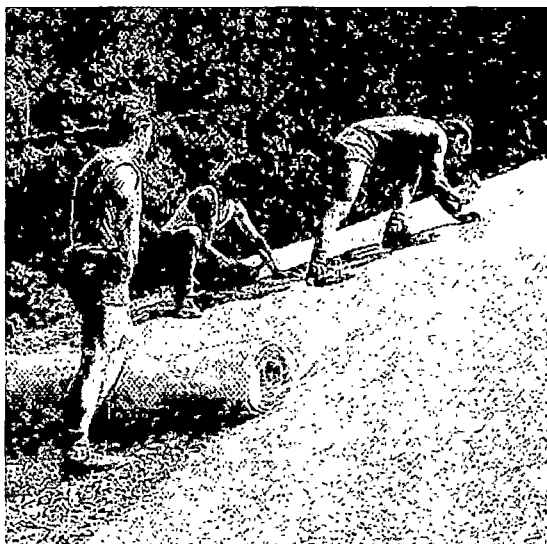
Foto 5.17 Instalación de la Biomanta.
