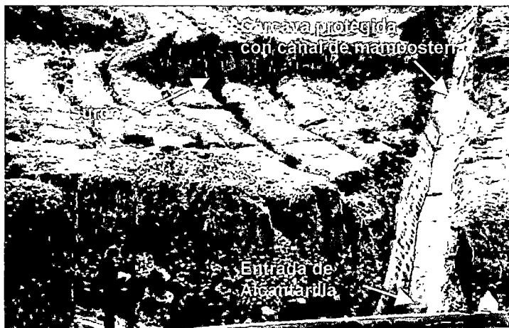
Foto 3.1 Se observa erosión hídrica con drenaje paralelo formando surcos en depósitos fluvio-glaciales. Nótese terrazas y surco cárcava como canal receptor, también se observa que la cárcava se trata de proteger con zanja de mampostería (Km. 1+900 de la Carretera La Oroya – Pte. Matachico).
