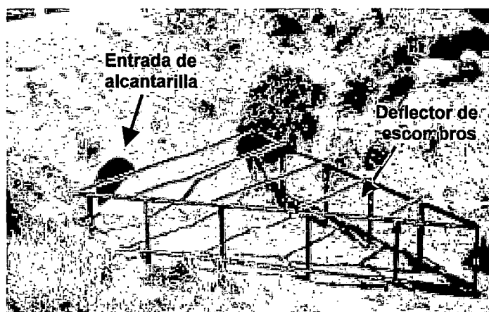
Foto 5.5 Estructura deflectora de escombros de barras de acero.
