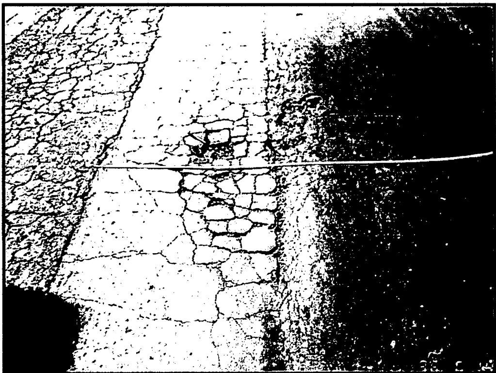
Foto 3.1: Fallas Piel de Cocodrilo
