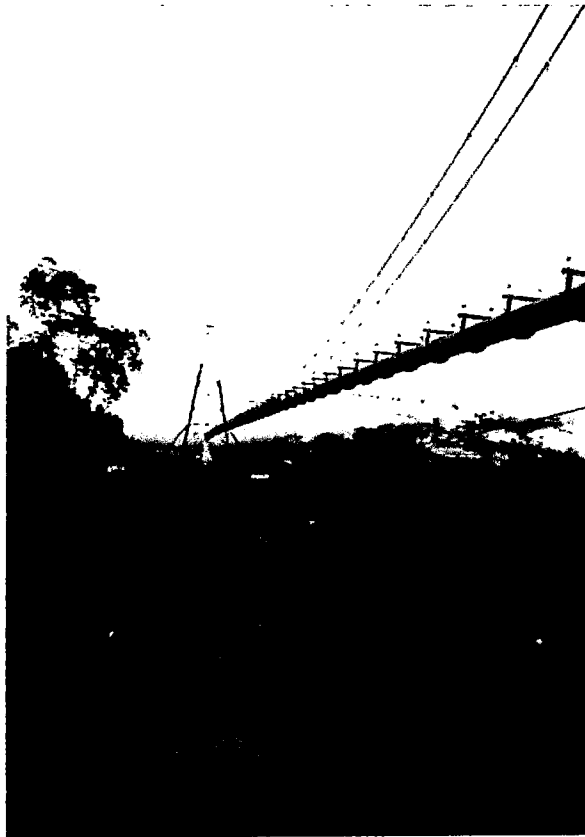
Foto 4: Oleoducto Nor Peruano - Proceso de montaje.
