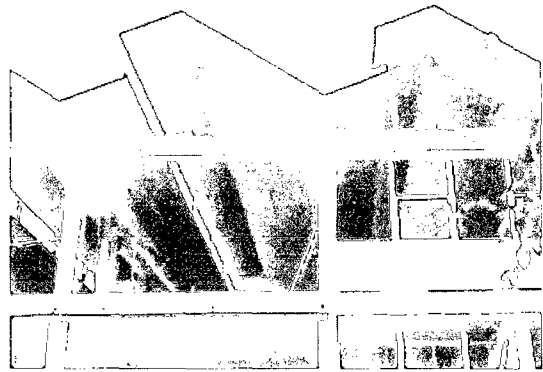
Foto 042. Cubierta de placa delgada en ferrocemento
