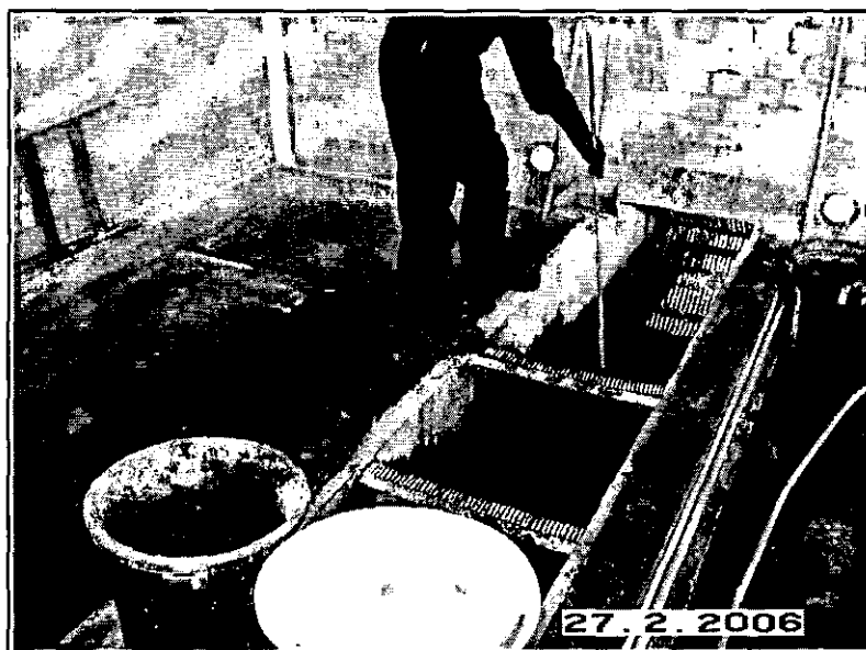
Foto 4.20 Limpieza manual de canal conductor
