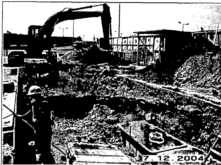
Instalación de tuberías para telecomunicaciones en playa de estacionamiento
