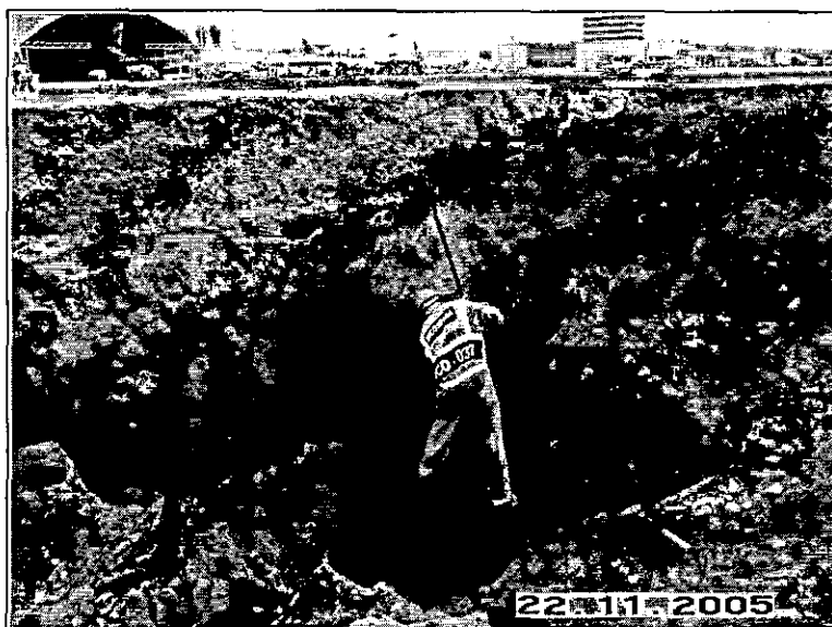
Reposición de losa de pista de taxiway. Toma de muestra de suelo.
