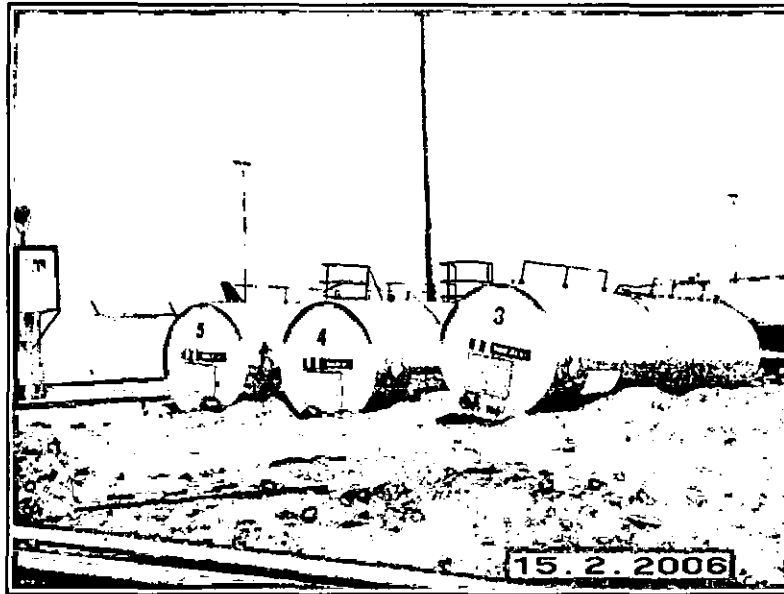
Foto 4.14 Tanques de combustibles para desecho.
