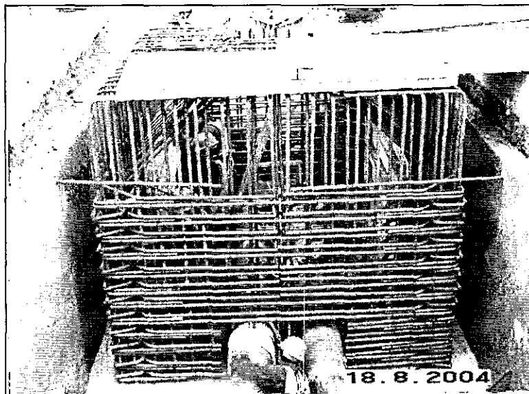
Acero de refuerzo para joint box en plataforma
