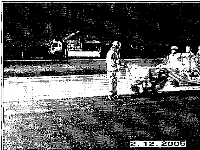
Trabajos nocturnos. Mantenimiento pista de aterrizaje
