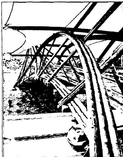
Figura N.º 1.4 Arco compuesto por 6 guaduas. Jörg Stamm. (Proyecto UTP-GTZ. Pereira, Colombia, 2001).
