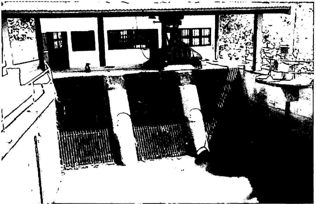
Fig. 2.15b. Rejas con mecanismo motorizado de limpieza
