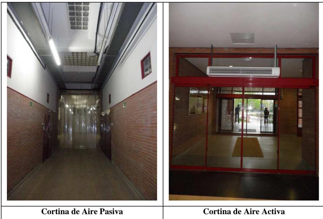
**Figura 34: Cortina de aire pasiva y activa instalada en la EII - UVa.**
