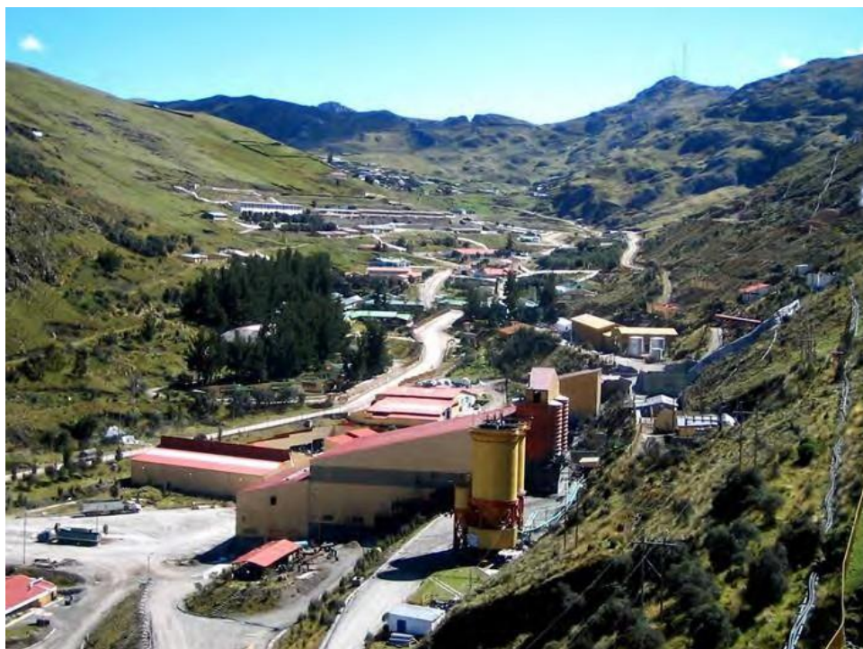
Figura 1.2: Zona de extracción
