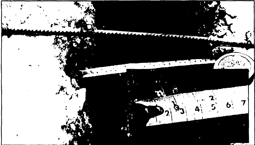
Figura 04-40 – Se observa una sobre-excavación de 5.5cm de ancho con respecto a la plantilla.
