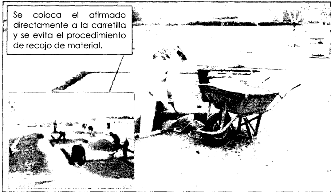
Figura 04-33 – Procedimiento de eliminación.
