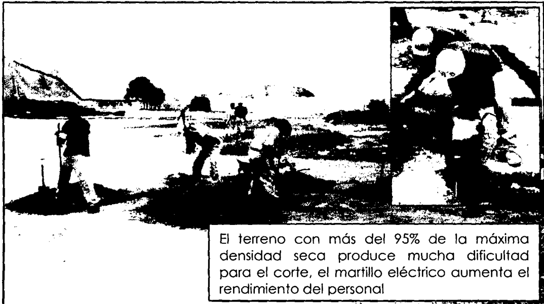
Figura 04-31 – Perfilado con barreta y corte con pico o martillo eléctrico
