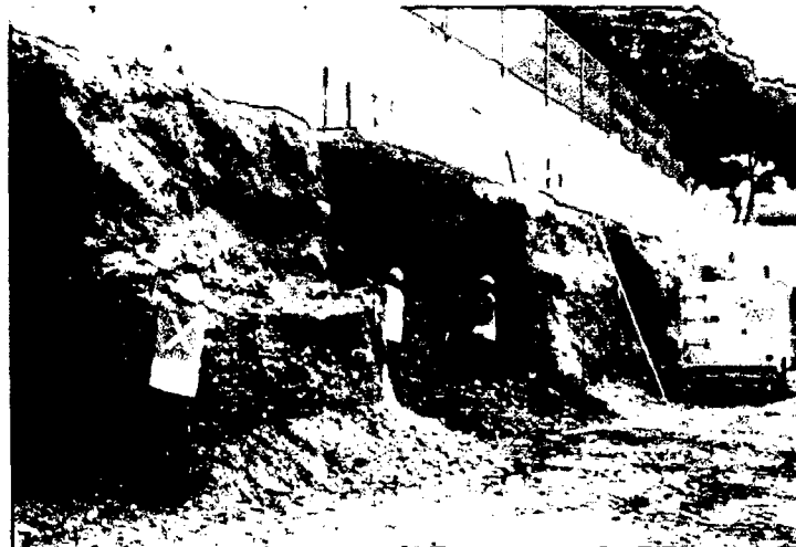
Perfilado vertical de los paños donde se construirán los Muros Pantalla. Se observa el tendón inclinado que formará parte del anclaje.
