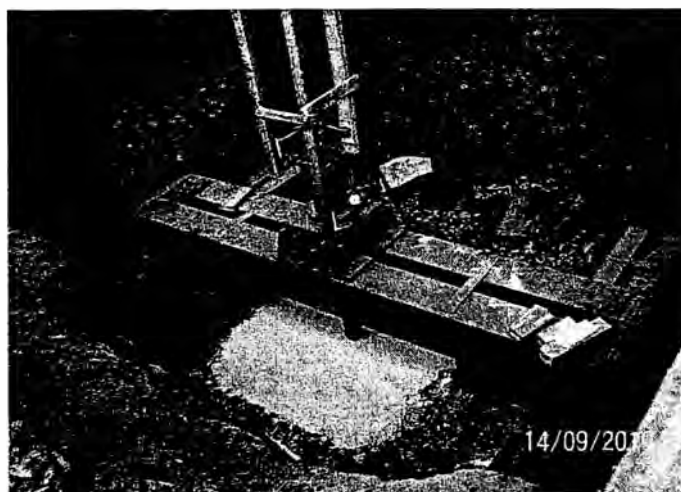
Fig 4. Estructura lista para el ensayo de arrancamiento
