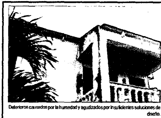
Fotografía 5. Deterioro causado por la humedad - Fuente: Artiles y Olivera, 2007.
