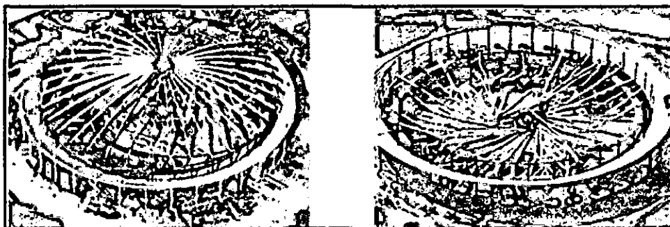
Figura 12. Falla de domo en construcción, Louisiana.
