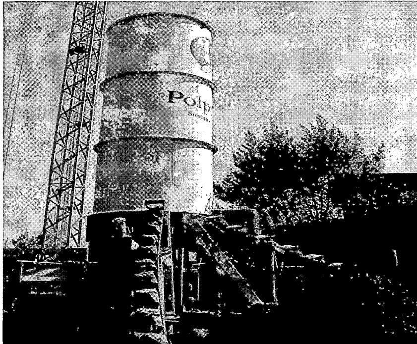
Foto N° 5: Planta de concreto en obra. Fuente: Propia.
