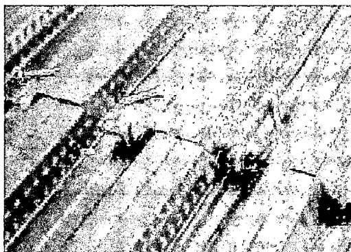
Figura 4.19 Conectores de corte
