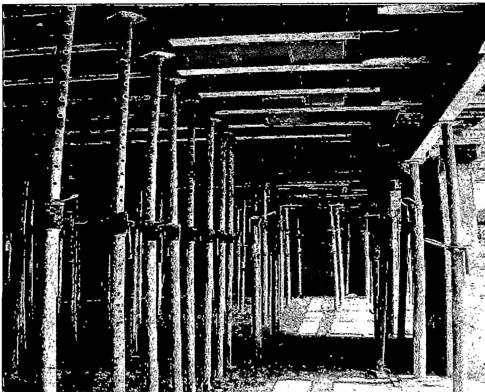
Figura 1.6 Posicionamiento de los puntales
