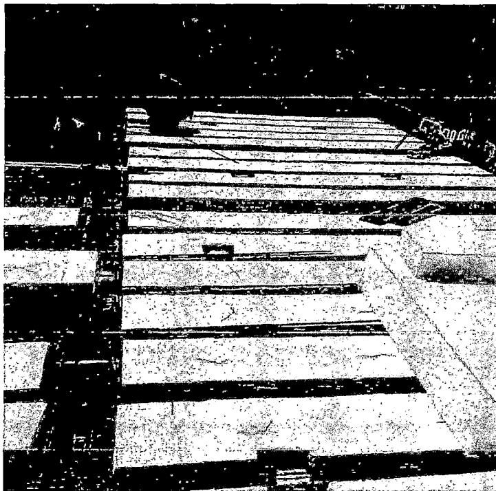
Figura 2.12 Colocación de las bovedillas de poliestireno
